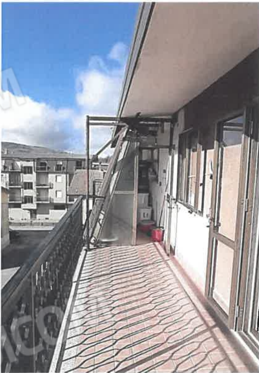
foto n. 17 - vista balcone - fronte sud
