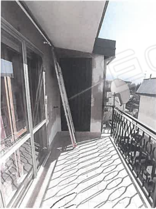
foto n. 19 - vista balcone - fronte sud
