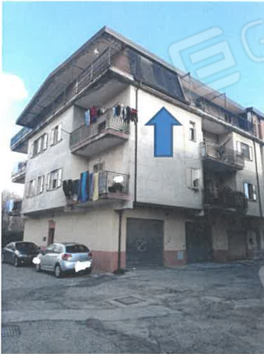
foto n. 1 - prospetto Località La Prisa – fronte sud-ovest
