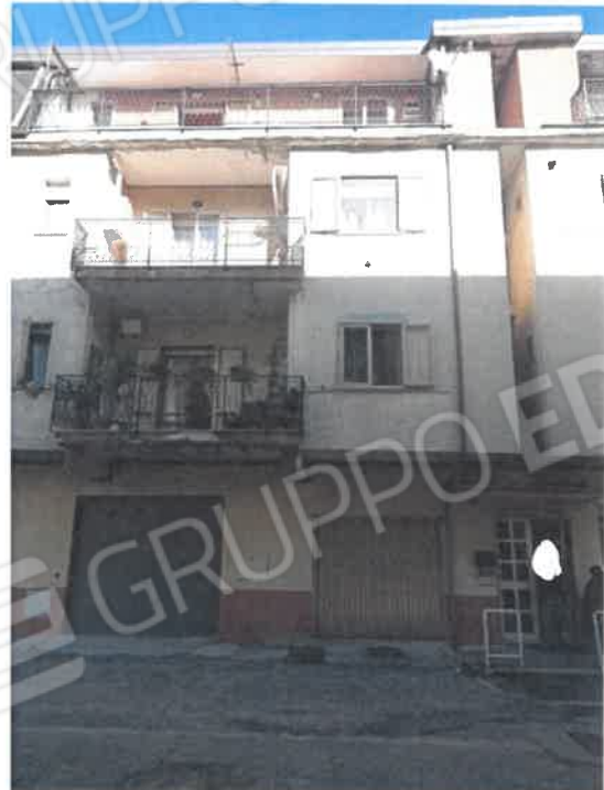
foto n. 2 -prospetto ingresso Località La Prisa - fronte sud
