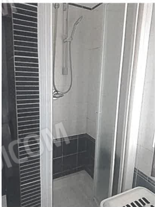
foto n. 13 - particolare box doccia
