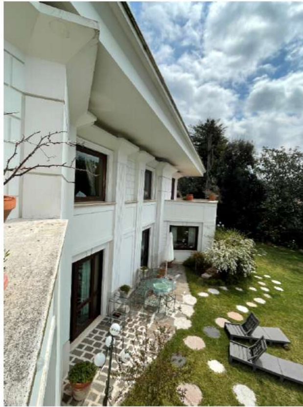
Prospetto su area esterna a sud-ovest
