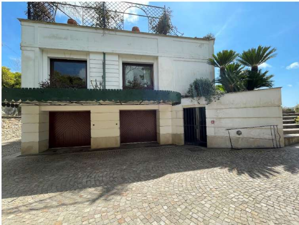
Ingressi al garage sulla facciata nord-ovest
