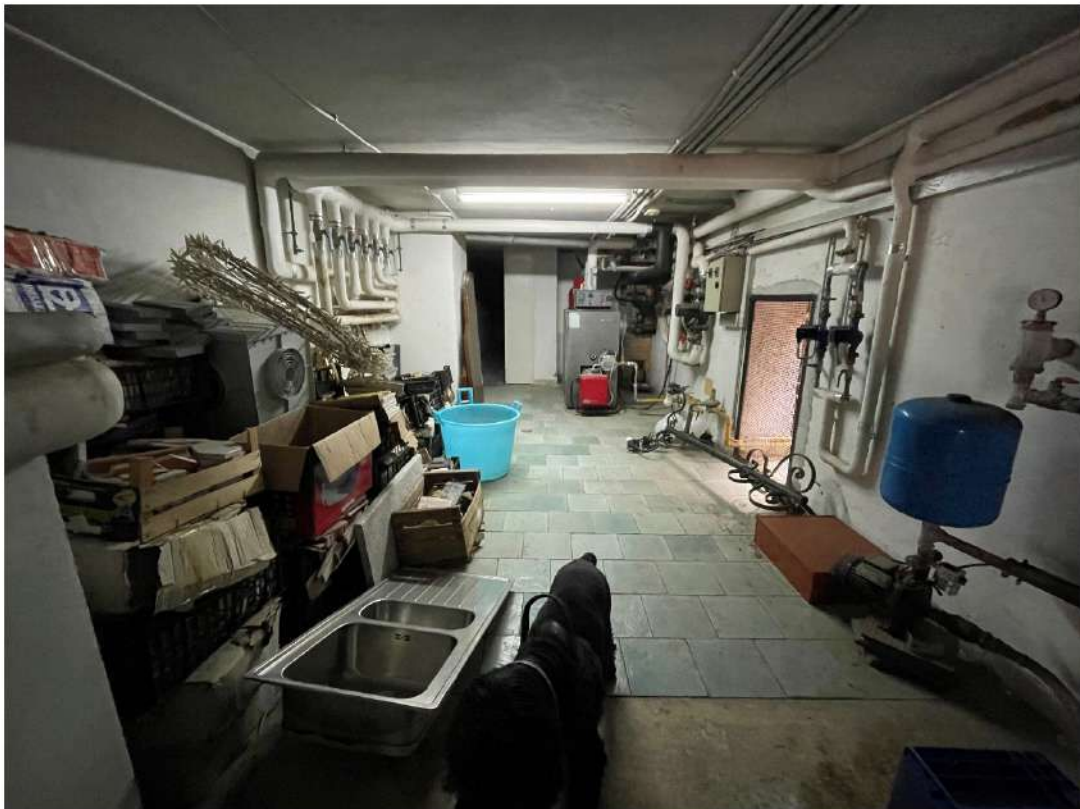
Locali tecnici e deposito
