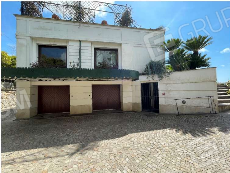
Ingressi al garage sulla facciata nord-ovest
