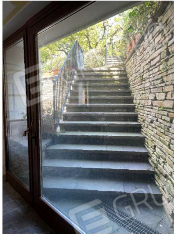
Scale di accesso al piano seminterrato dall'area esterna di pertinenza esclusiva
