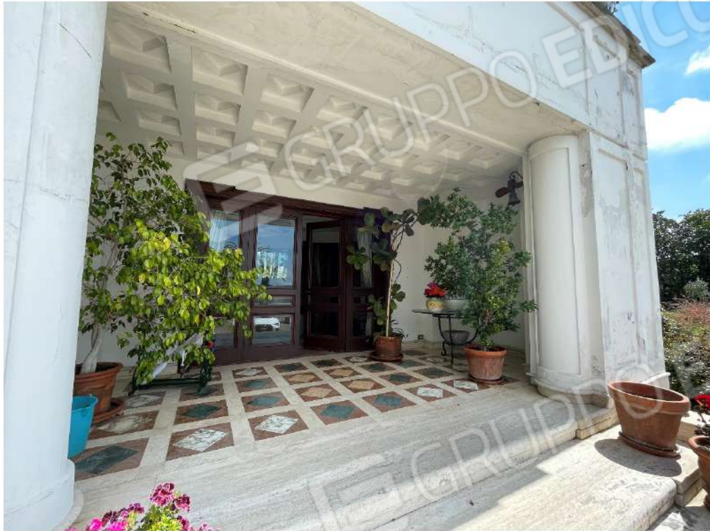
Ingresso principale al piano terra parte esterna
