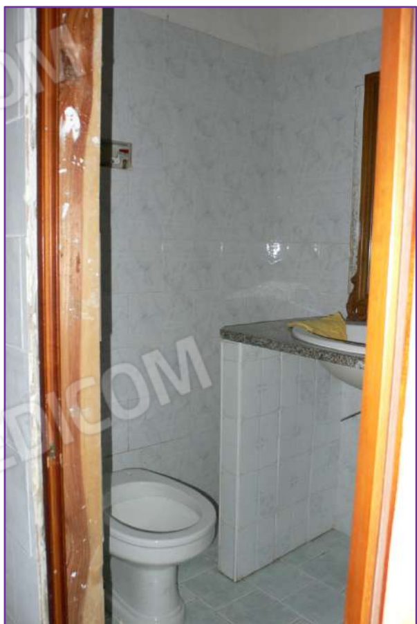
Foto n. 28 – Bagno 1 p. S1 (altra vista)
