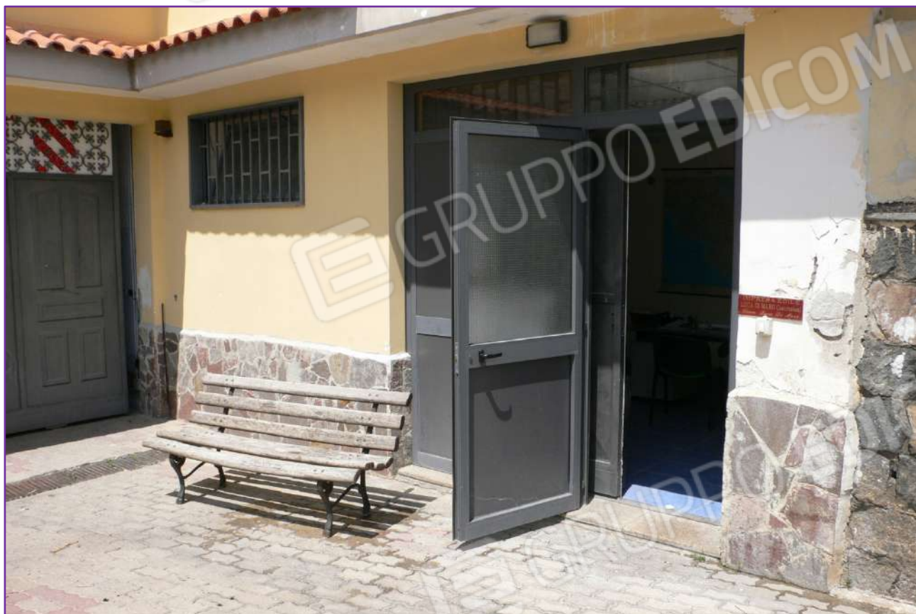
Foto n. 30 – Porta d'ingresso locale adibito ad ufficio
