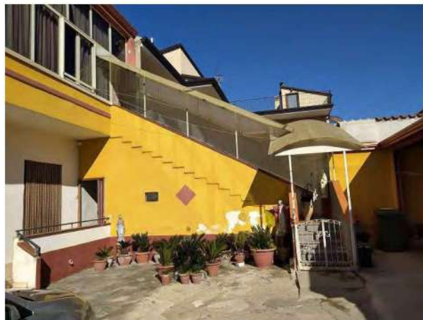
Vista dal cortile pertinenziale
