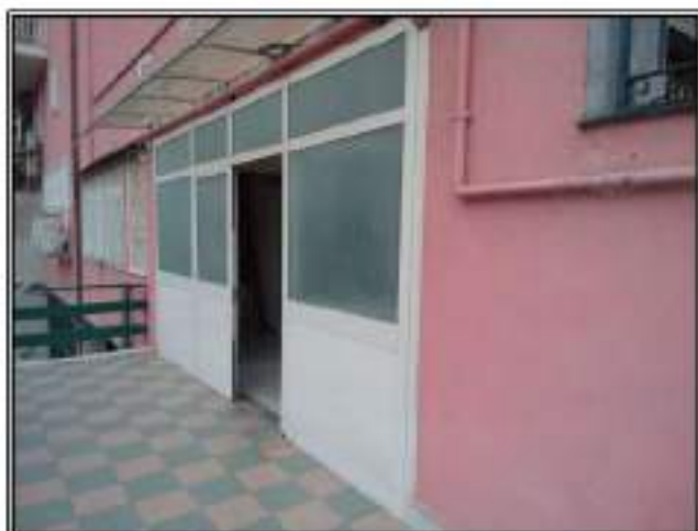
Figura 19 ingresso piano primo interrato
