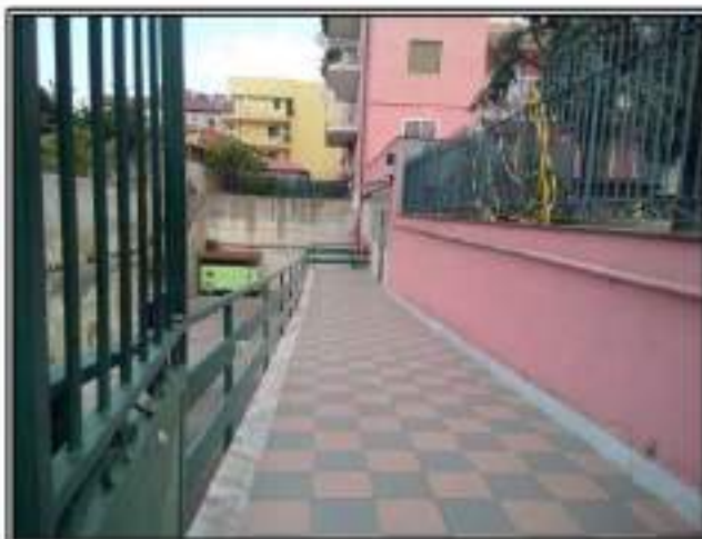
Figura 18 rampe di accesso al piano primo interrato
