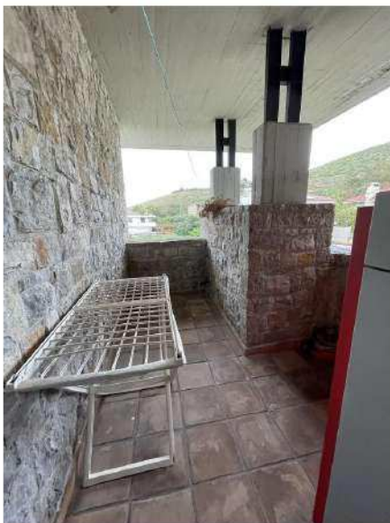
Foto 45: balcone lato ovest
