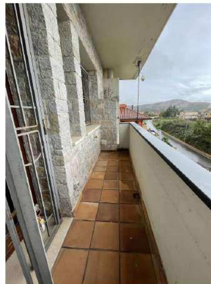
Foto 46: balcone lato est
