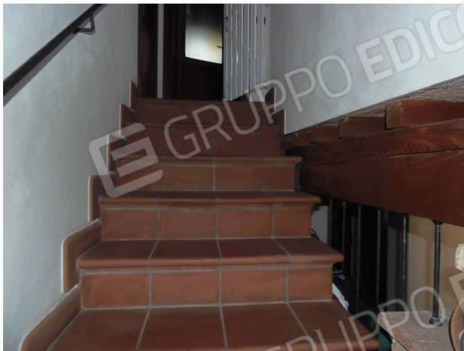
(Foto scala che conduce al piano primo)
