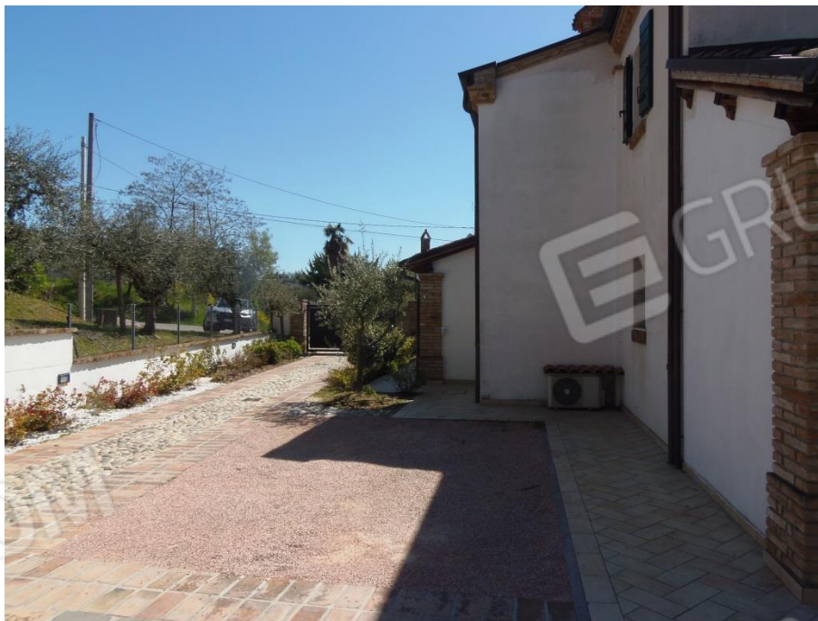
(Foto area cortilizia adibita a camminamenti pedonali e carrabili con una pavimentazione in “porfido” e inserti di ghiaia con una parte a ghiaino)
