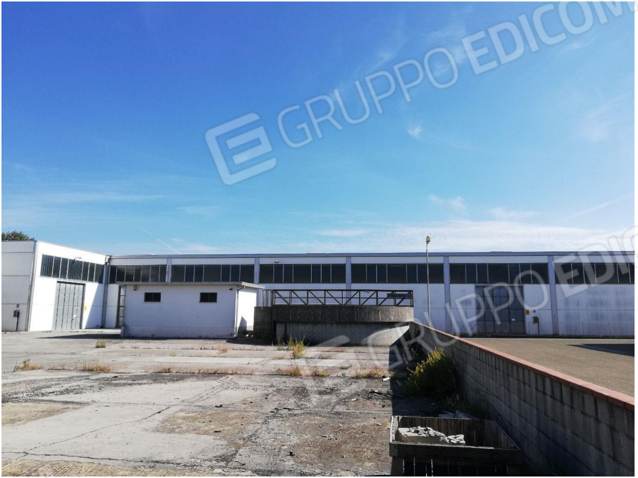
Figura 2 VISTA ESTERNA LOTTO 2
