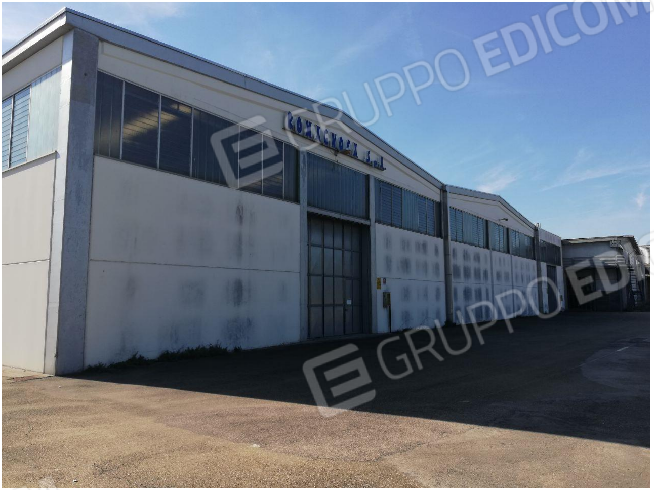
Figura 3 VISTA RETRO LOTTO 2
