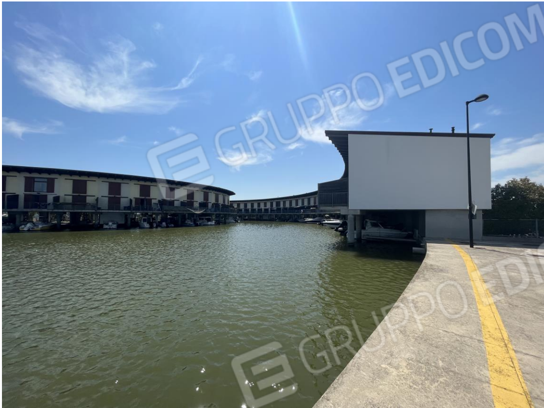
Vista del complesso da nord
