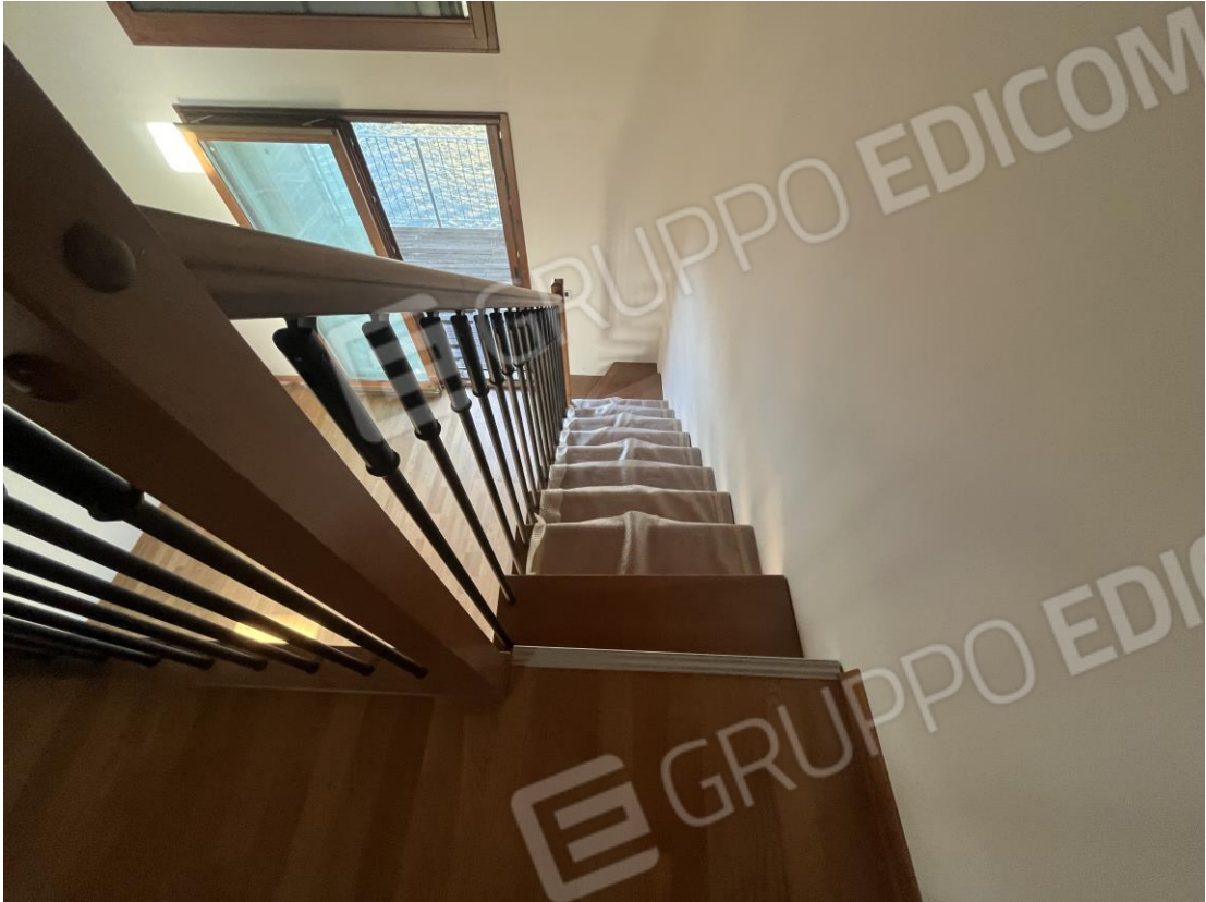
Scala di accesso al soppalco/sottotetto
