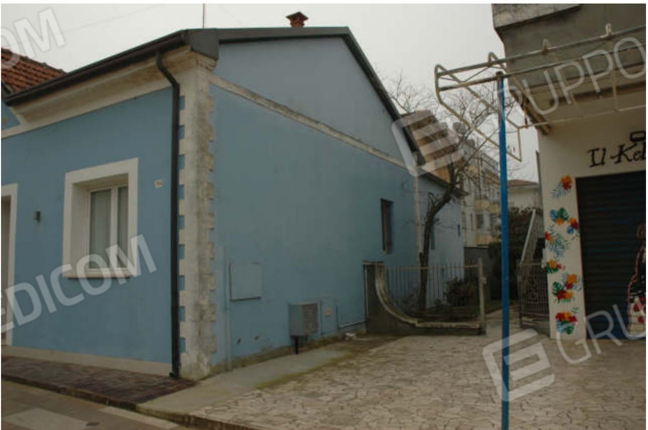
Foto 2 - Prospetto, lato N/W a confine con altra proprietà
