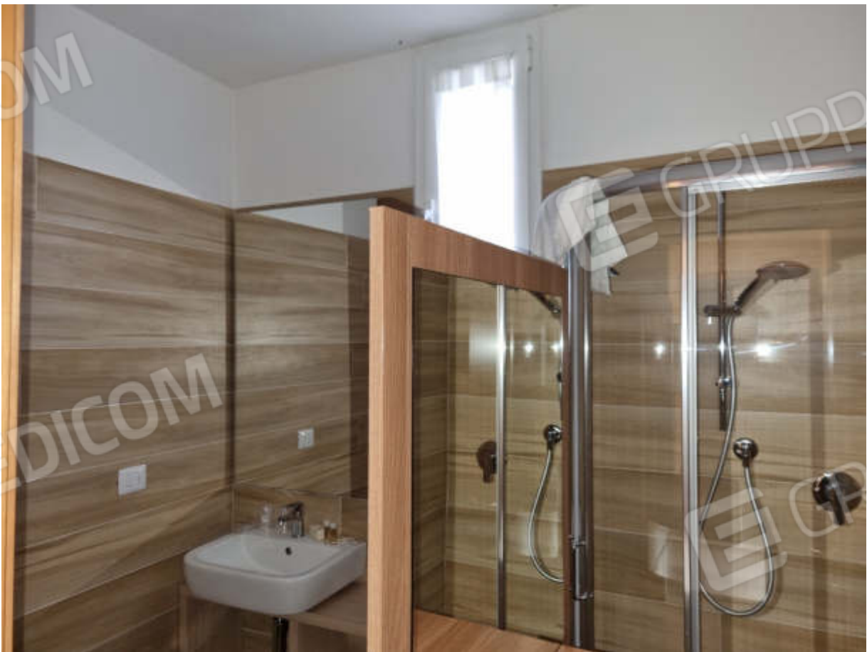
Foto 14 - Bagno con rivestimento h cm. 220
