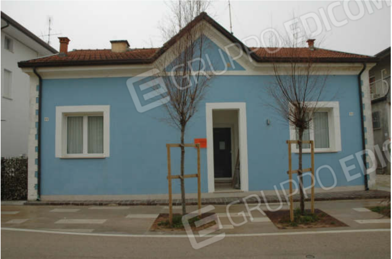
Foto 1 - Prospetto lato mare del fabbricato
