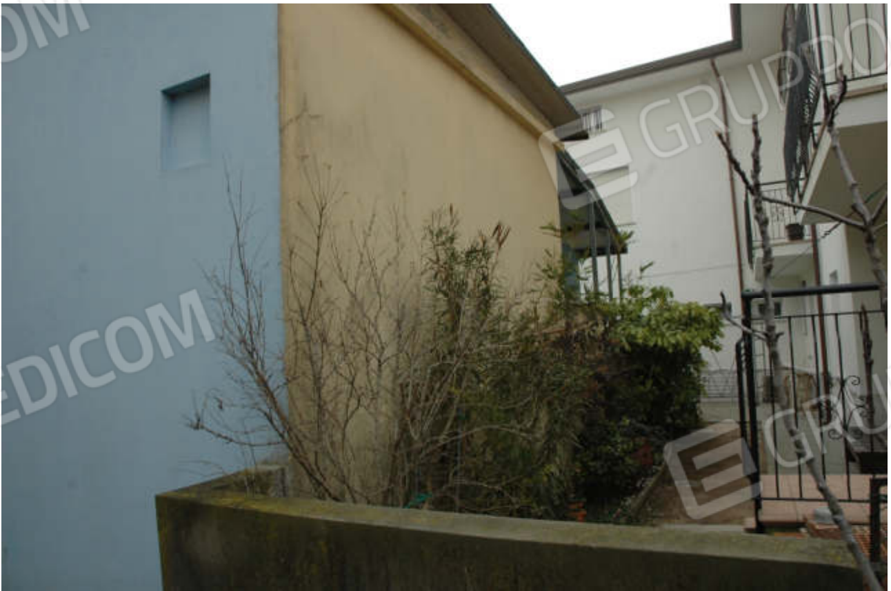
Foto 20 - Vista sul confine lato monte
