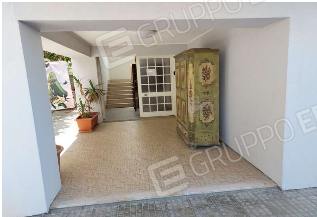
portico con ingresso comune
