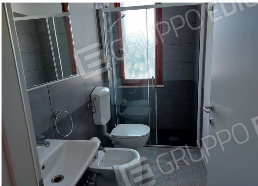
bagno al P3 sub 13
