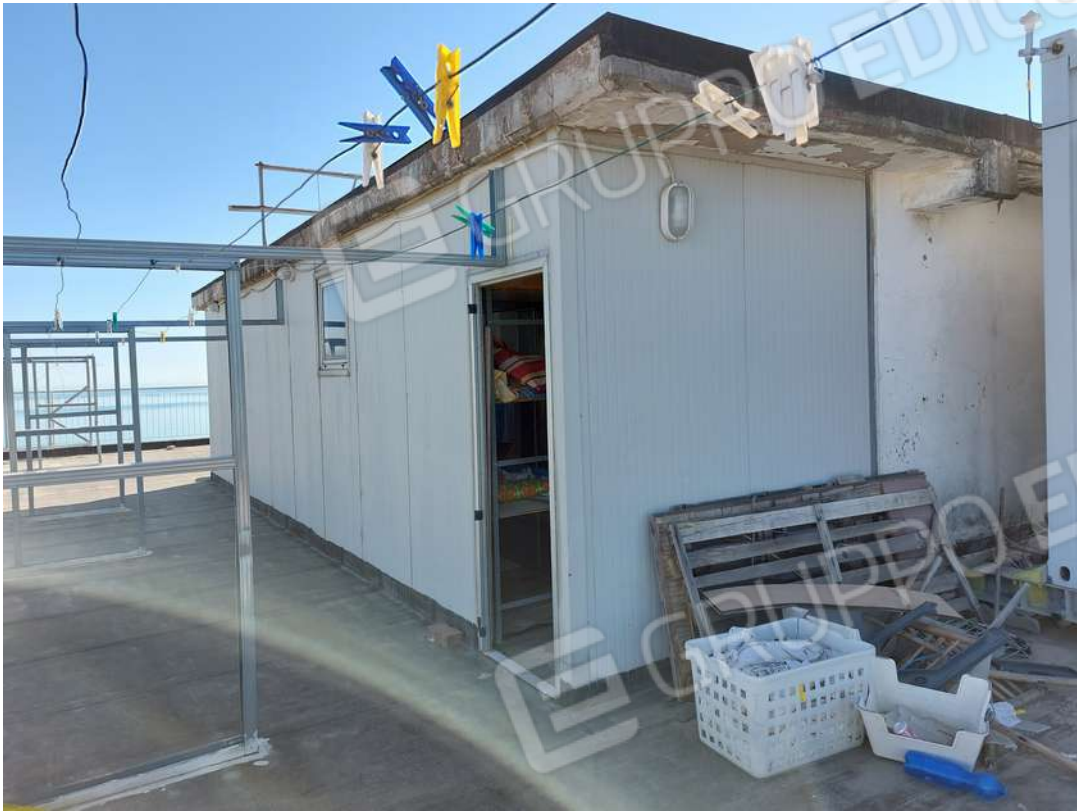
locali sul lastrico solare
