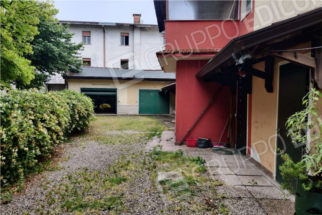
Foto n. 3 – Area scoperta comune su retro del fabbricato.
