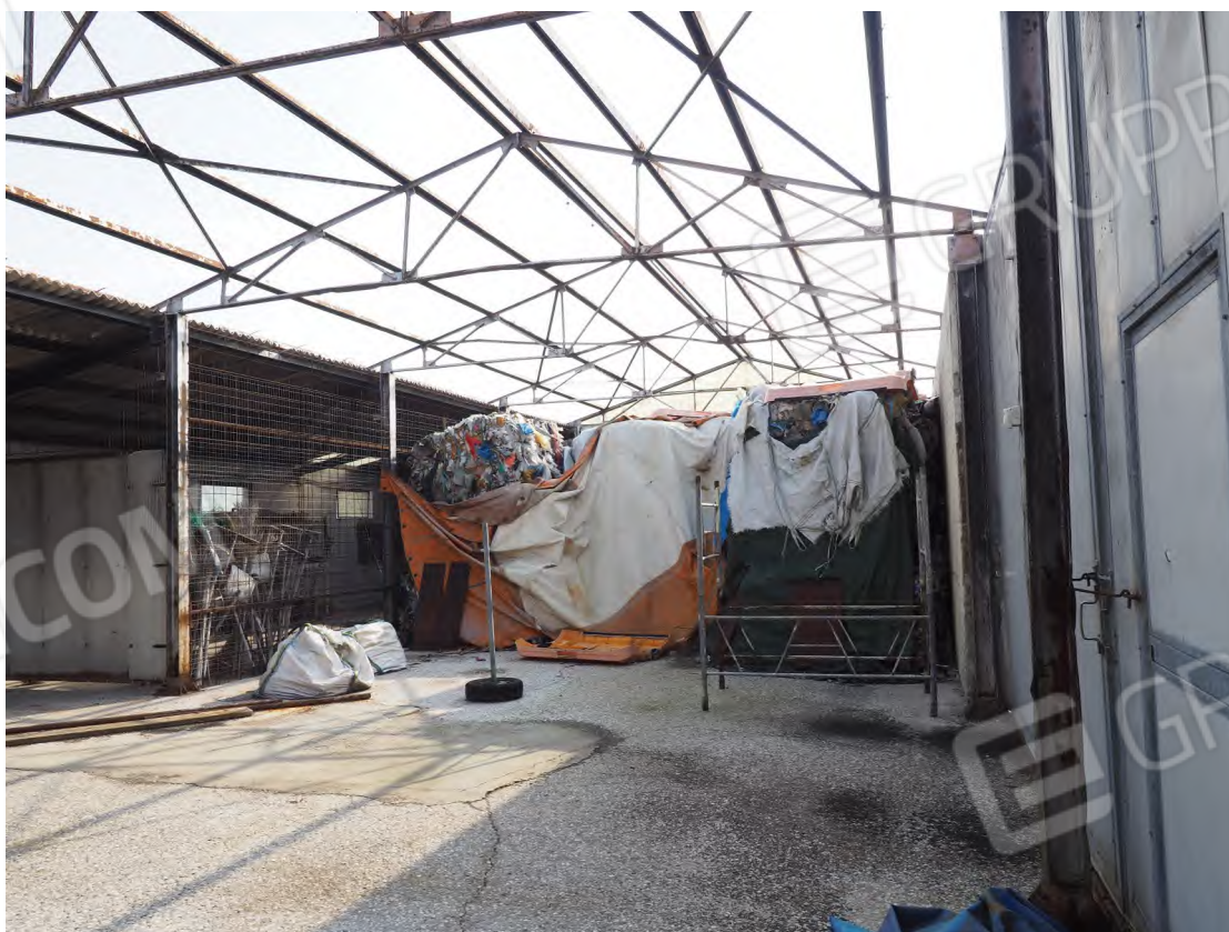
Caorle, strada Riello n. 2 – L'interno del capannone.
