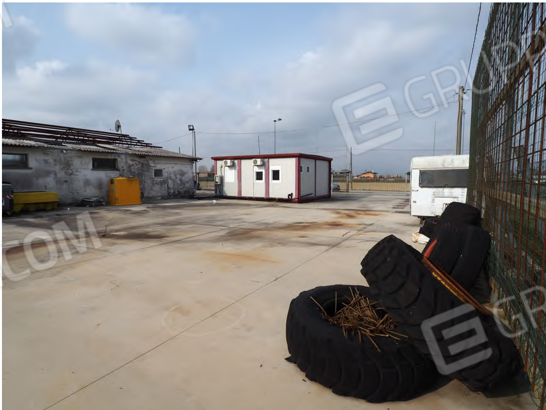
Caorle, strada Riello n. 2 – Il prospetto nord del capannone industriale, il prefabbricato e lo scoperto - area di manovra.
