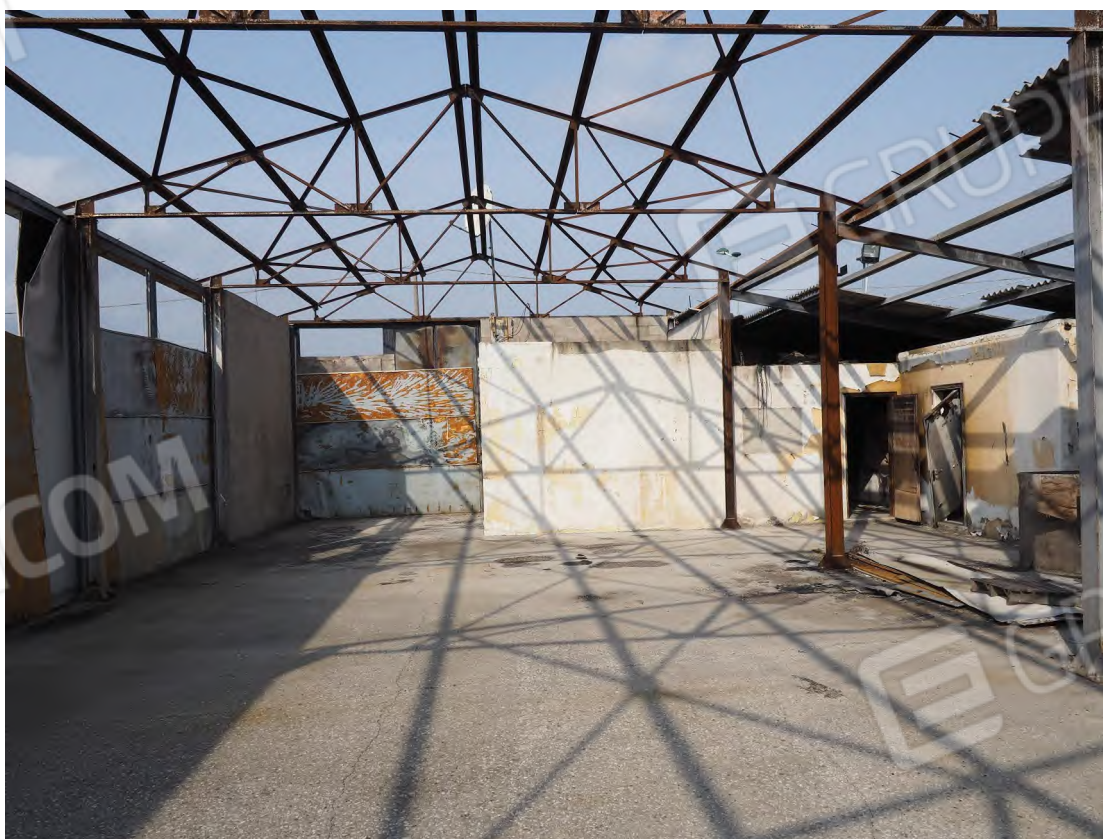
Caorle, strada Riello n. 2 – L'interno del capannone.
