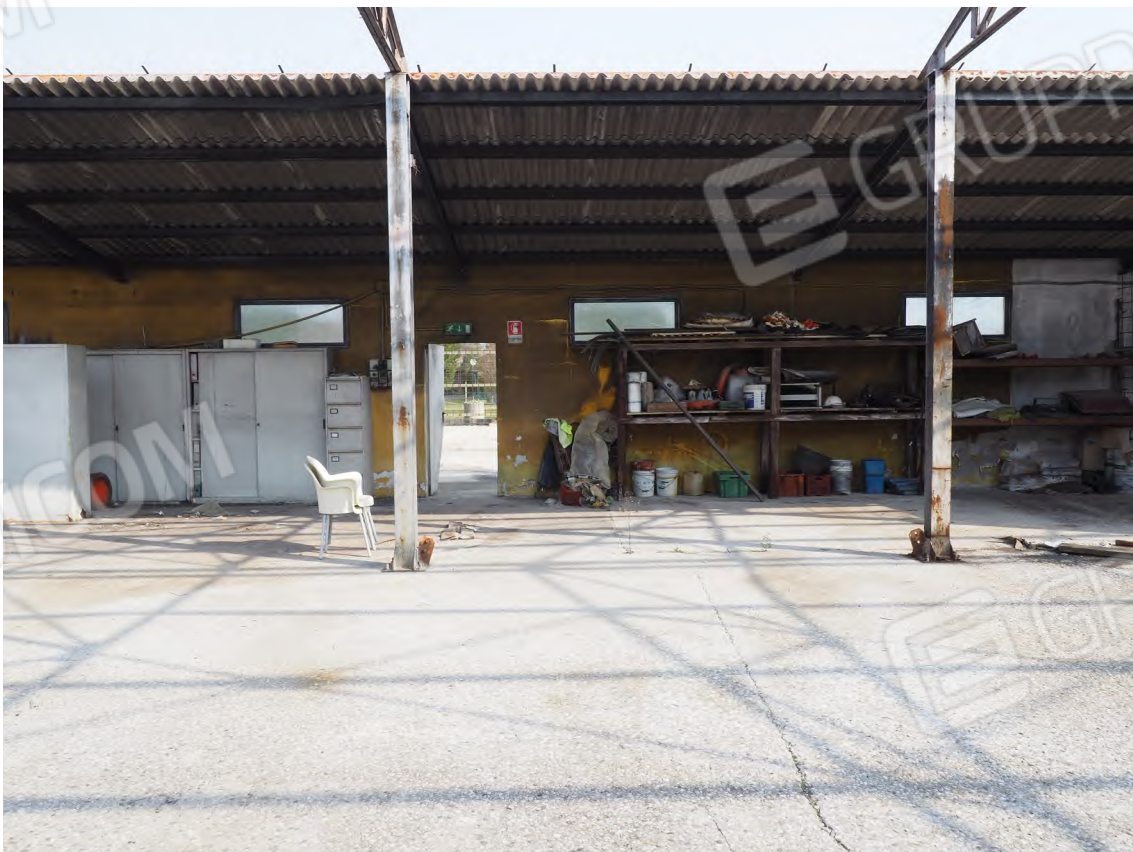
Caorle, strada Riello n. 2 – L'interno del capannone.
