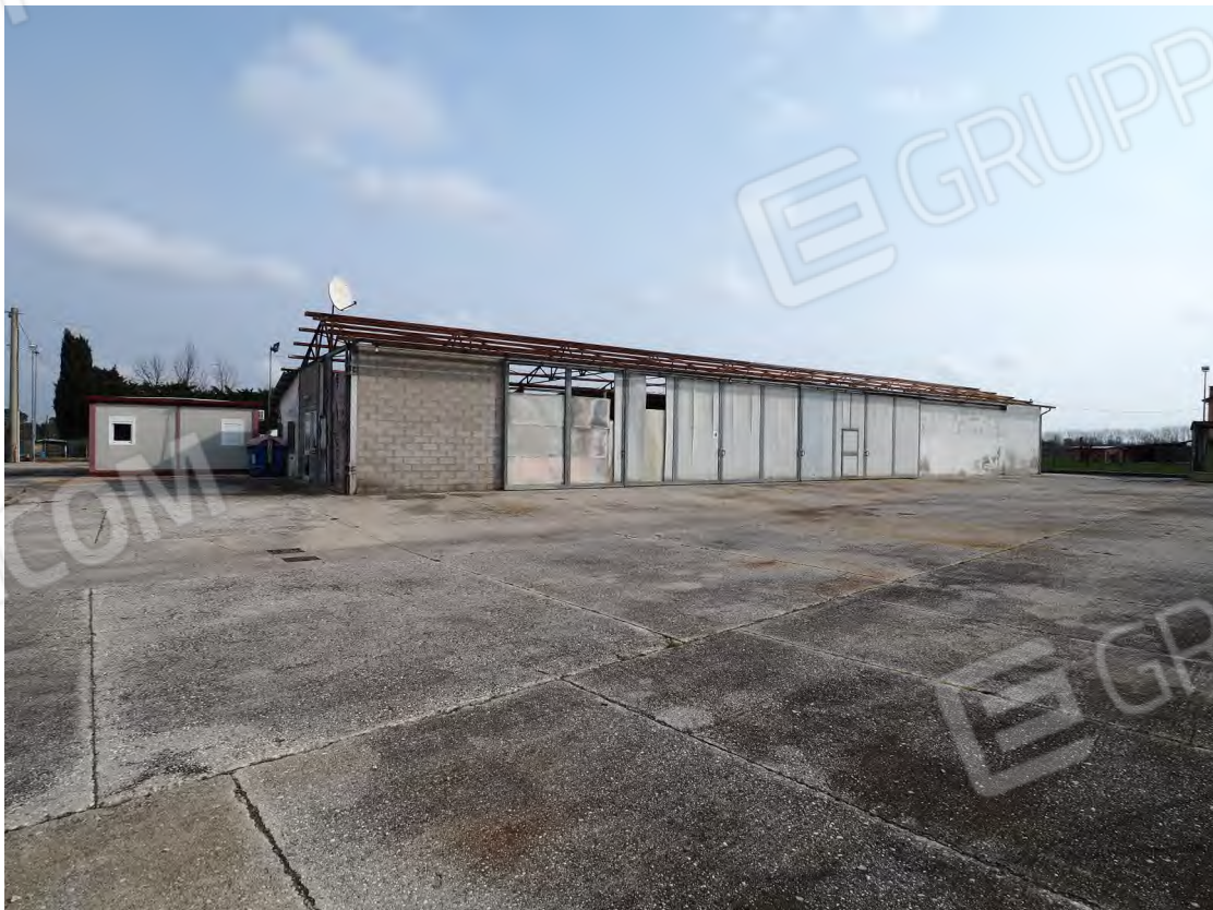
Caorle, strada Riello n. 2 – Il prospetto sud del capannone industriale e lo scoperto - area di manovra.
