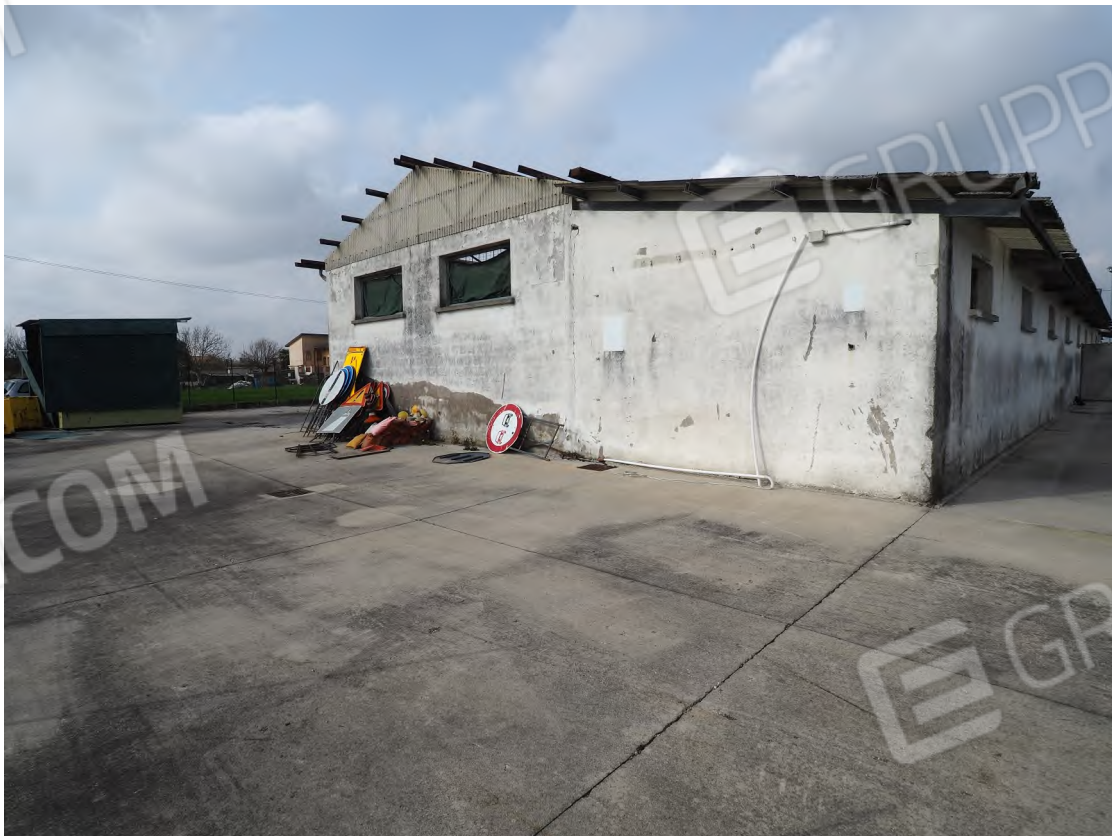
Caorle, strada Riello n. 2 – Il prospetto est del capannone industriale e lo scoperto - area di manovra.
