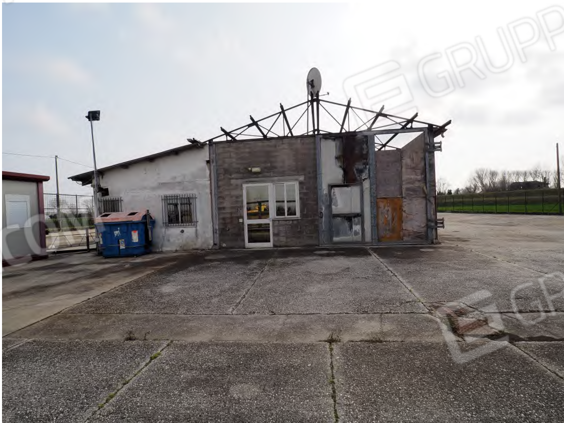
Caorle, strada Riello n. 2 - Sopra vista dall'alto del capannone industriale, sotto il prospetto ovest del fabbricato.
