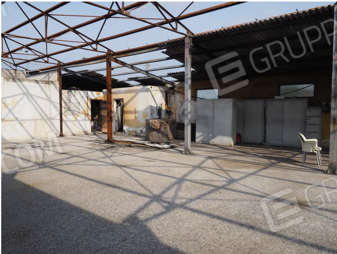
Caorle, strada Riello n. 2 – L'interno del capannone.
