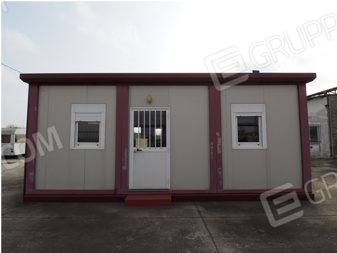
Caorle, strada Riello n. 2 - Il prefabbricato.
