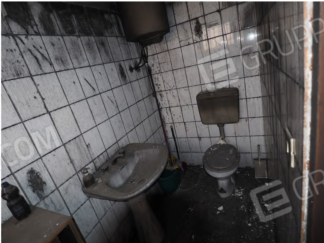
Caorle, strada Riello n. 2 - Il locale wc .
