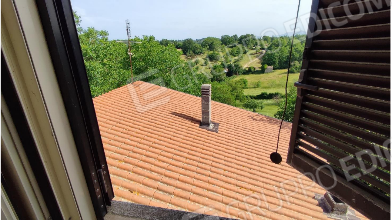
FOTO 14 vista mano copertura
