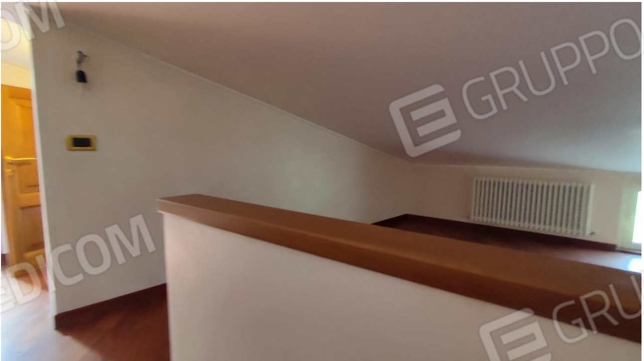
FOTO 9 vano sottotetto (non previsto in progetto)
