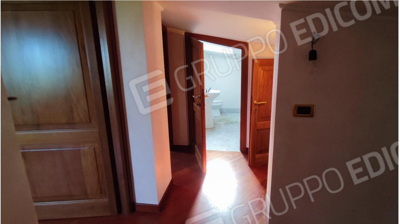
FOTO 10 vista bagno piano secondo (non previsto in progetto)
