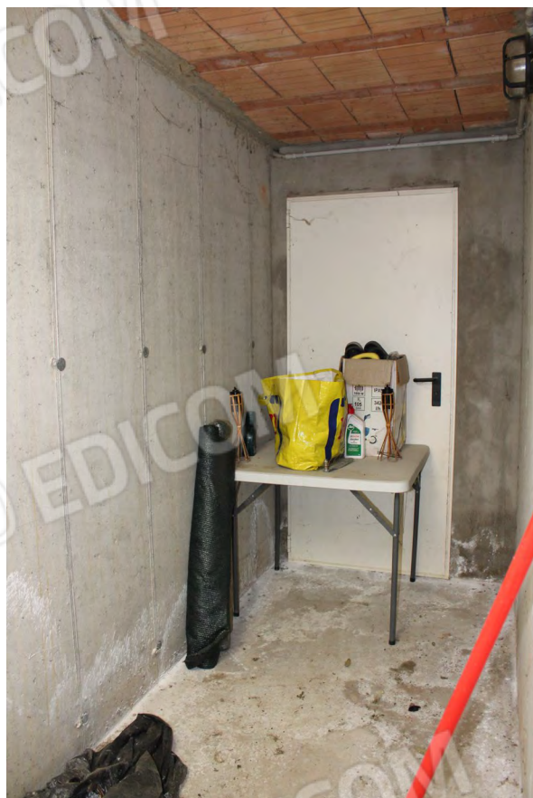
Intercapedine con porta verso vano scala
