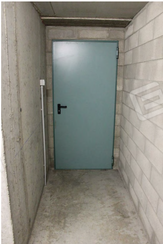
Porta accesso da piano interrato ai box
