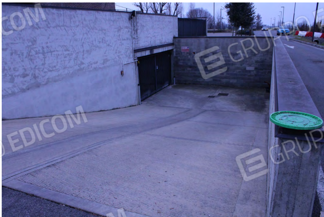
Rampa accesso piano interrato
