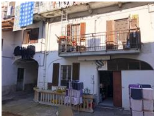
Vista del fabbricato dalla corte interna
