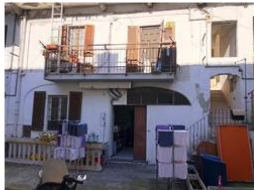
Vista del fabbricato dalla corte interna
