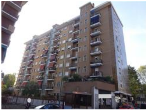
Vista da via Bellini
