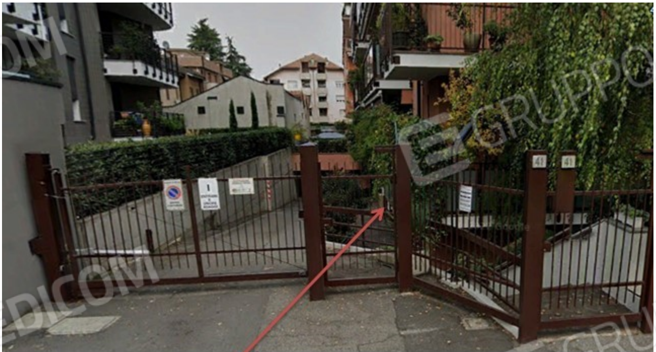
Appartamento al piano seminterrato – quota cortile
