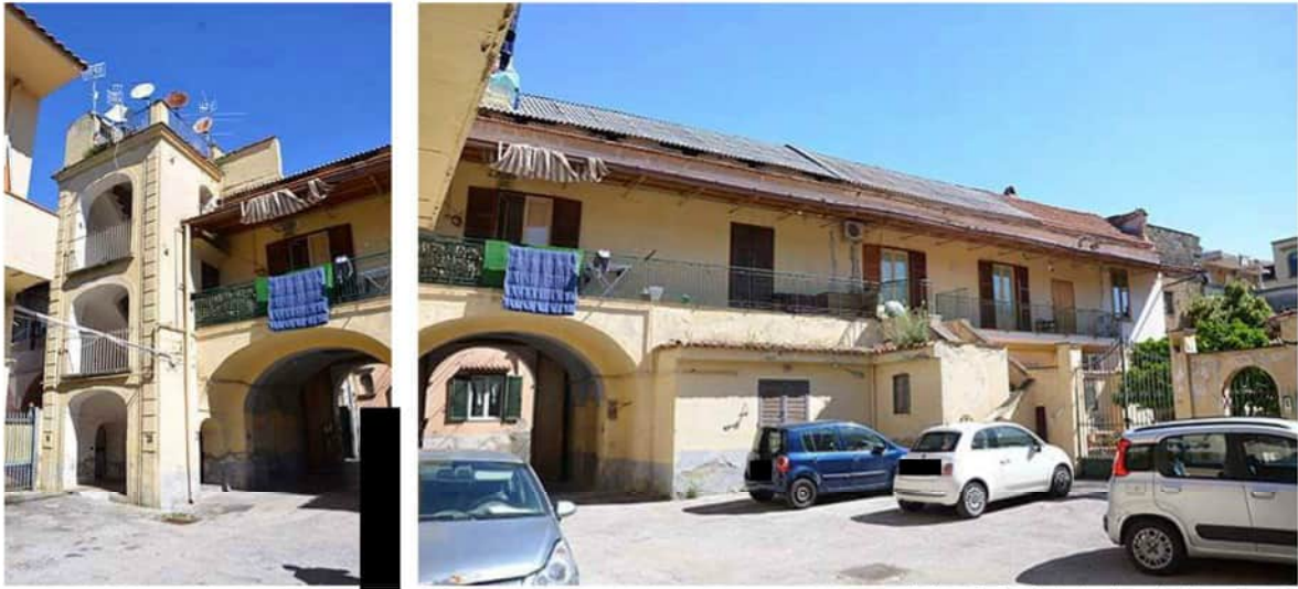
_viste del fabbricato dalla strada
