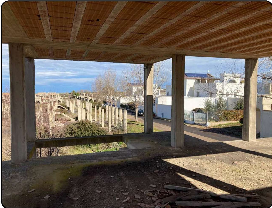
Foto 27: Vista di dettaglio dell'interno del Piano Primo di un corpo di fabbrica in costruzione in stato di abbandono relativa ad una villa del tipo Rossi 2 (cfr. Immagine 1 - cono visivo 2)
