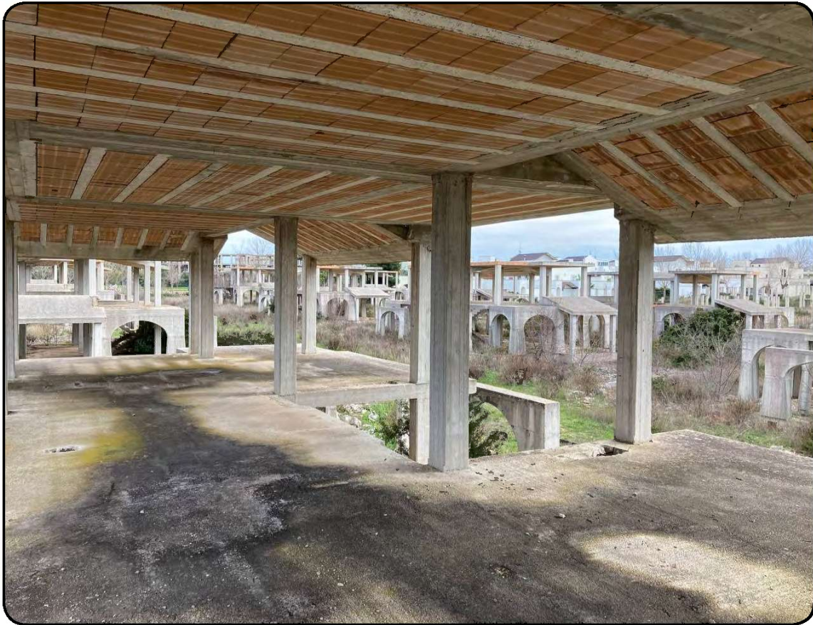
Foto 45: Vista di dettaglio dell'interno del Piano Primo di un corpo di fabbrica in costruzione in stato di abbandono relativa ad una villa del tipo Vietti 1 (cfr. Immagine 1 - cono visivo 21)
