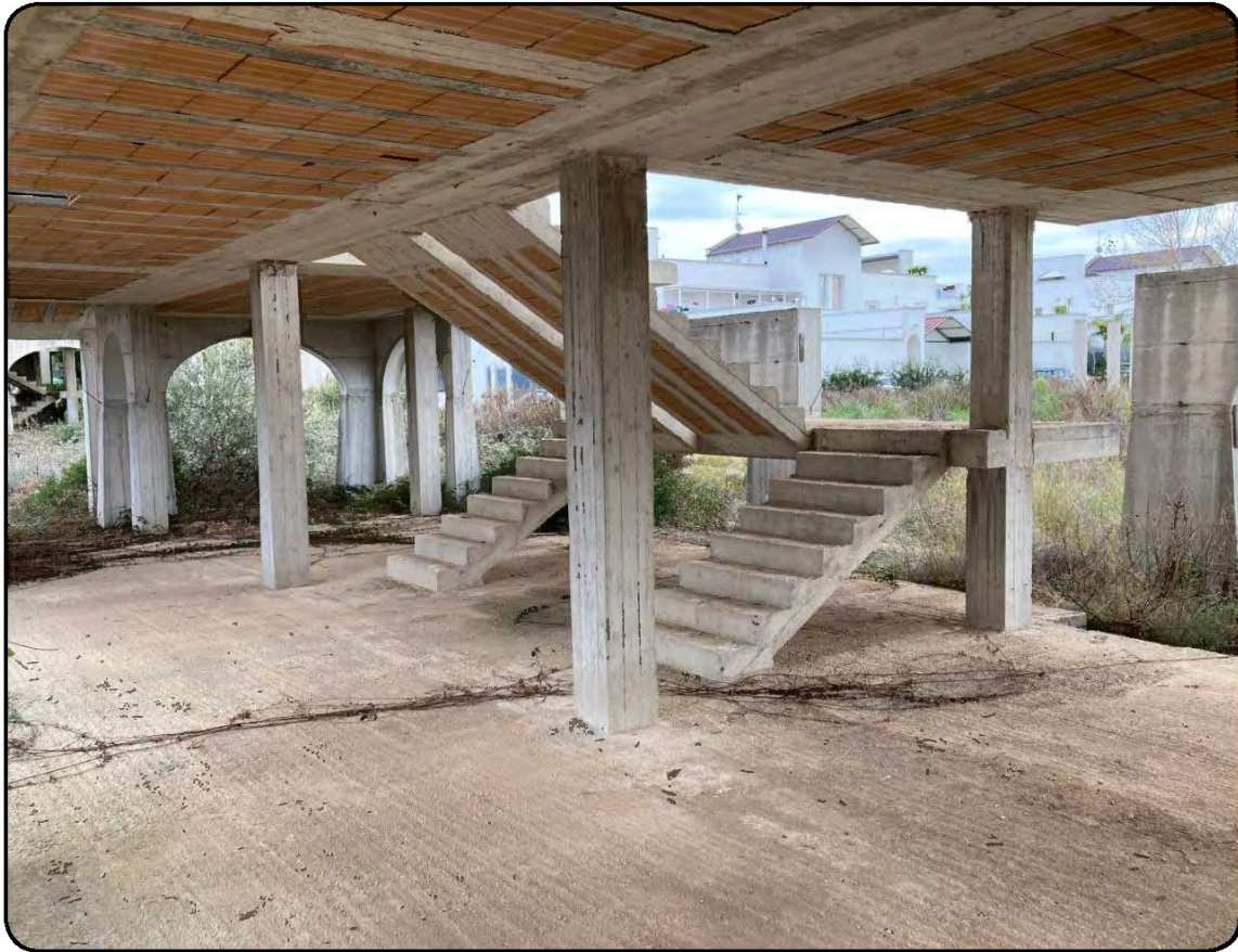
Foto 34: Vista di dettaglio dell'interno del Piano Terra di un corpo di fabbrica in costruzione in stato di abbandono relativa ad una villa del tipo Vietti 2 (cfr. Immagine 1 - cono visivo 18)
