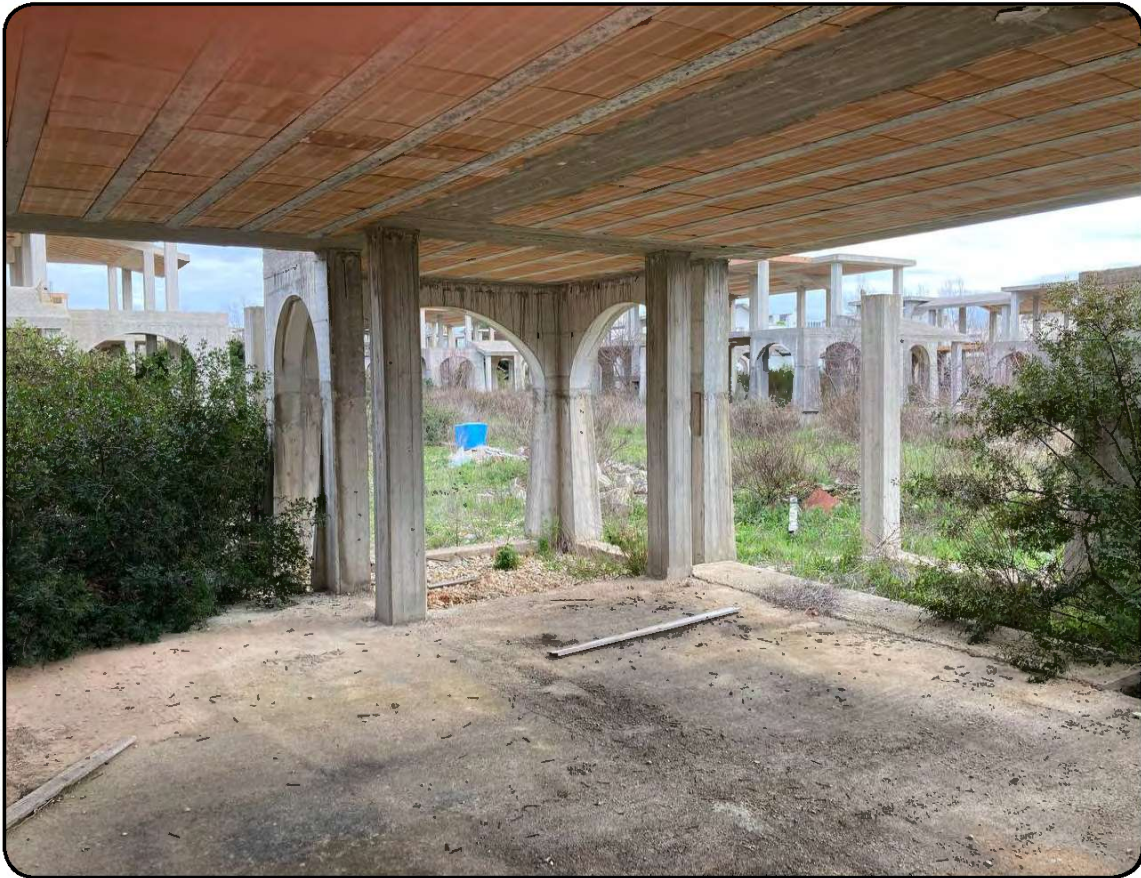
Foto 43: Vista di dettaglio dell'interno del Piano Terra di un corpo di fabbrica in costruzione in stato di abbandono relativa ad una villa del tipo Vietti 1 (cfr. Immagine 1 - cono visivo 21)
