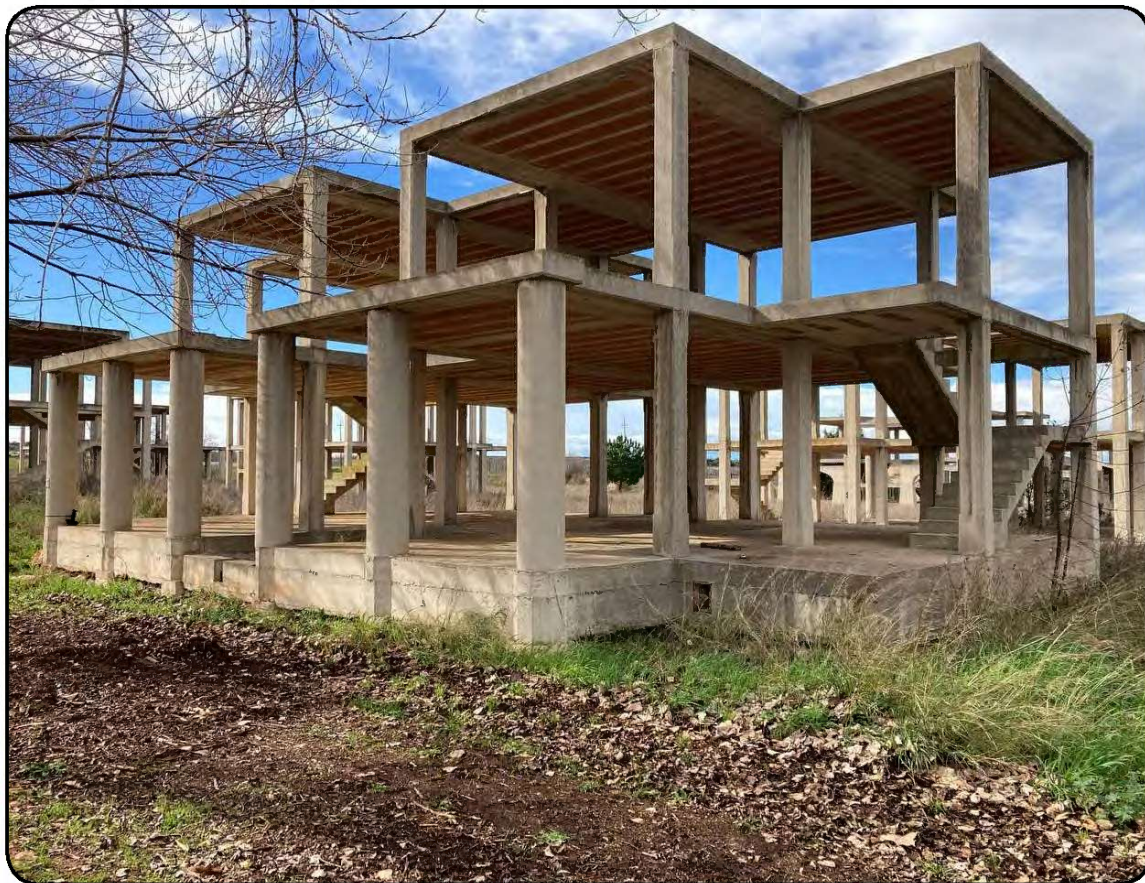
Foto 10: Struttura in c.a. di un corpo di fabbrica in costruzione in stato di abbandono relativa ad una villa del tipo Rossi 2 (cfr. Immagine 1 - cono visivo 4)
