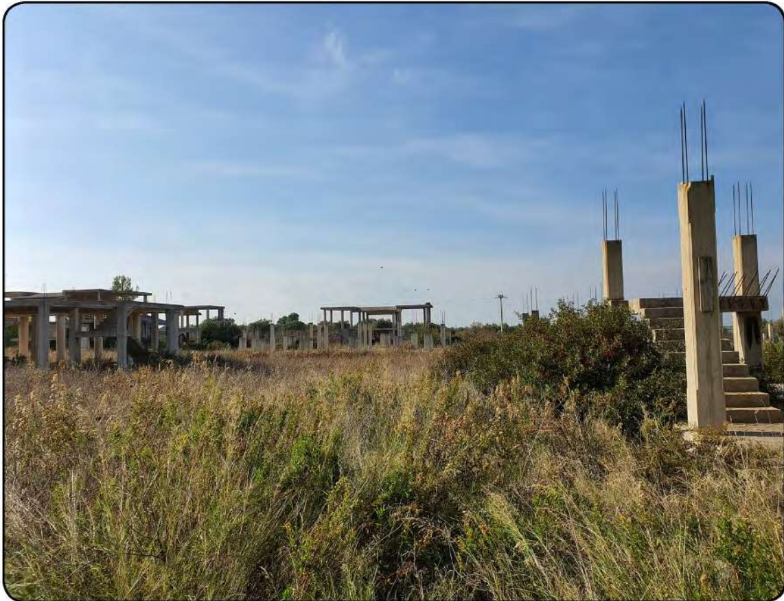
Foto 9: Strutture in c.a. della prima tesa dei pilastri dei corpi di fabbrica in costruzione in stato di abbandono relative alle ville del tipo Rossi 2 e del tipo Vietti 2
