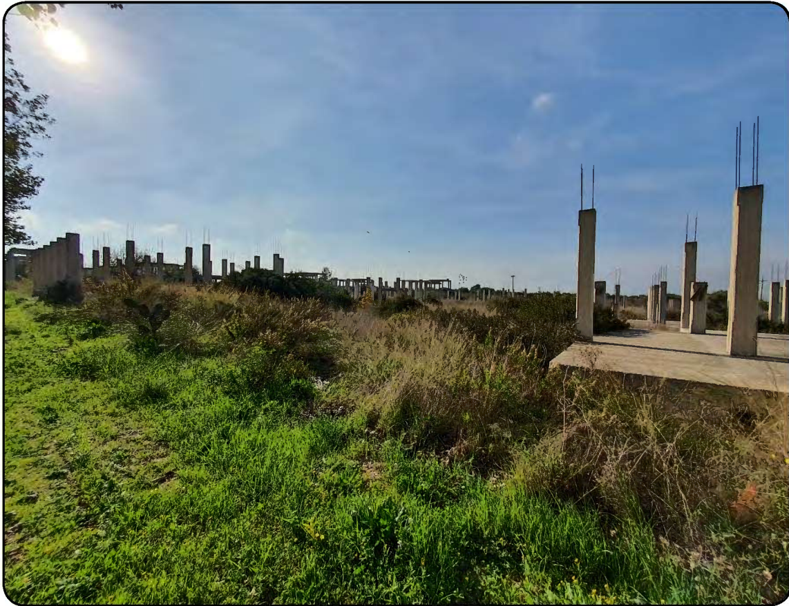
Foto 8: Strutture in c.a. della prima tesa dei pilastri dei corpi di fabbrica in costruzione in stato di abbandono relative alle ville del tipo Rossi 2 (cfr. Immagine 1 - cono visivo 3)
