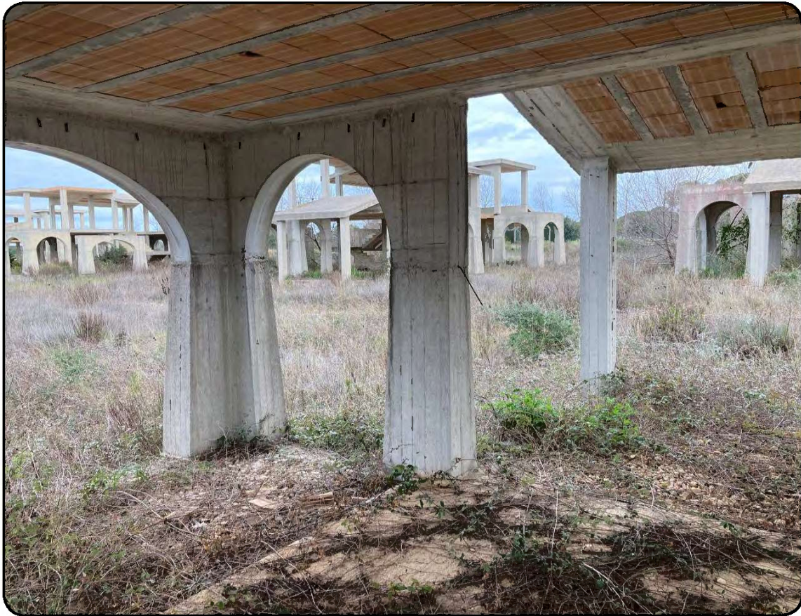
Foto 35: Vista di dettaglio dell'interno del Piano Terra di un corpo di fabbrica in costruzione in stato di abbandono relativa ad una villa del tipo Vietti 2 (cfr. Immagine 1 - cono visivo 18)
