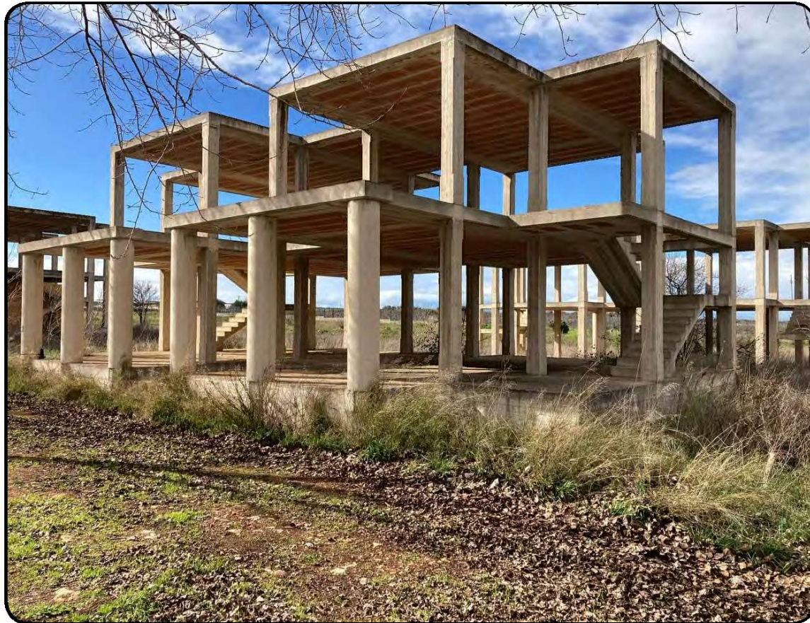
Foto 11: Struttura in c.a. di un corpo di fabbrica in costruzione in stato di abbandono relativa ad una villa del tipo Rossi 2 (cfr. Immagine 1 - cono visivo 5)
