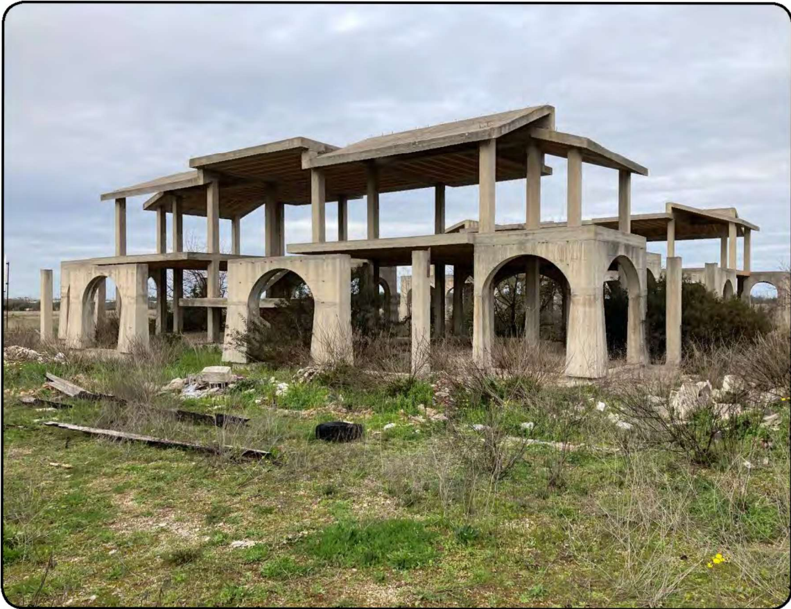
Foto 41: Struttura in c.a. di un corpo di fabbrica in costruzione in stato di abbandono, relativa ad una villa del tipo Vietti 1 (cfr. Immagine 1 - cono visivo 21)
