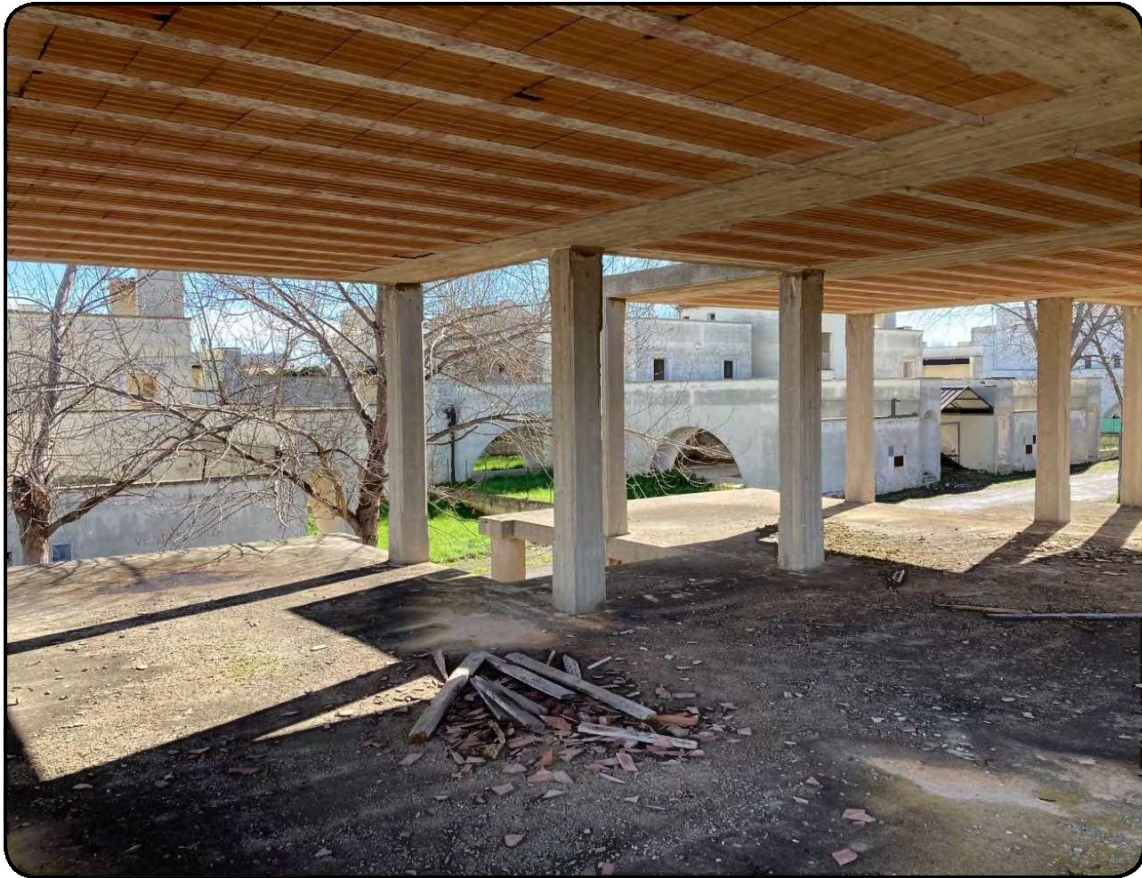
Foto 26: Vista di dettaglio dell'interno del Piano Primo di un corpo di fabbrica in costruzione in stato di abbandono relativa ad una villa del tipo Rossi 2 (cfr. Immagine 1 - cono visivo 2)
