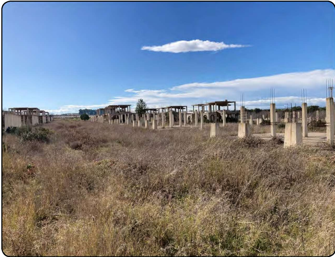
Foto 15: Strutture in c.a. della prima tesa dei pilastri dei corpi di fabbrica in costruzione in stato di abbandono relative alle ville del tipo Vietti 2 (cfr. Immagine 1 - cono visivo 9)
