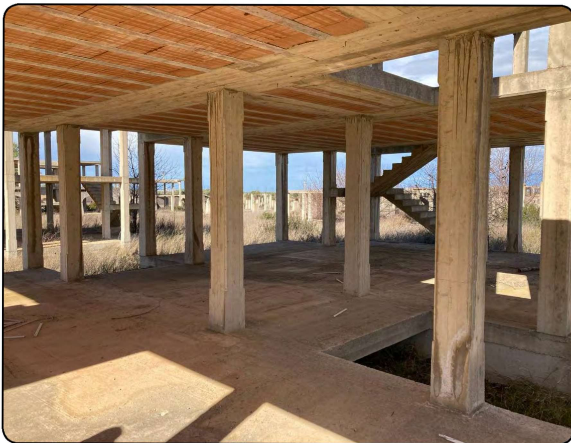
Foto 23: Vista di dettaglio dell'interno del Piano Terra di un corpo di fabbrica in costruzione in stato di abbandono relativa ad una villa del tipo Rossi 2 (cfr. Immagine 1 - cono visivo 2)
