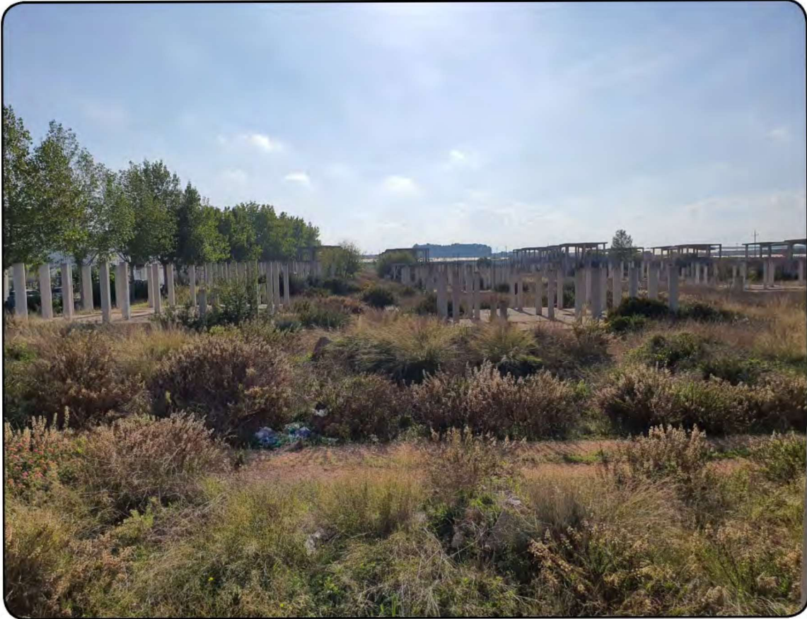
Foto 4: Strutture in c.a. della prima tesa dei pilastri dei corpi di fabbrica in costruzione in stato di abbandono relative alle ville del tipo Rossi 2 e del tipo Vietti 2 (cfr. Immagine 1 - cono visivo 1)
