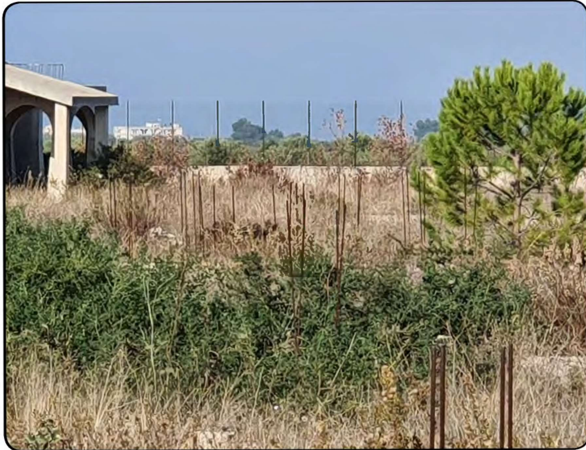
Foto 29: Ferri di attesa collocati nell'area ricadente sul lato Est dei suoli in stima
