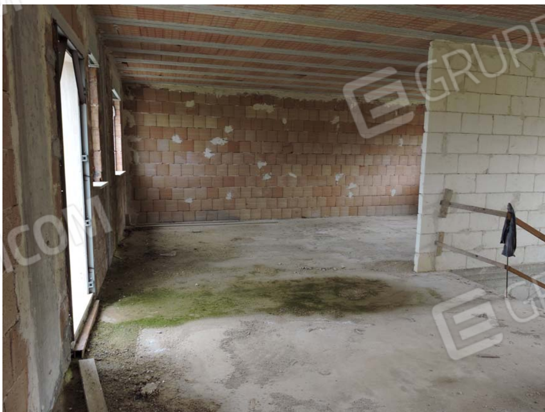
12. interno piano terra
