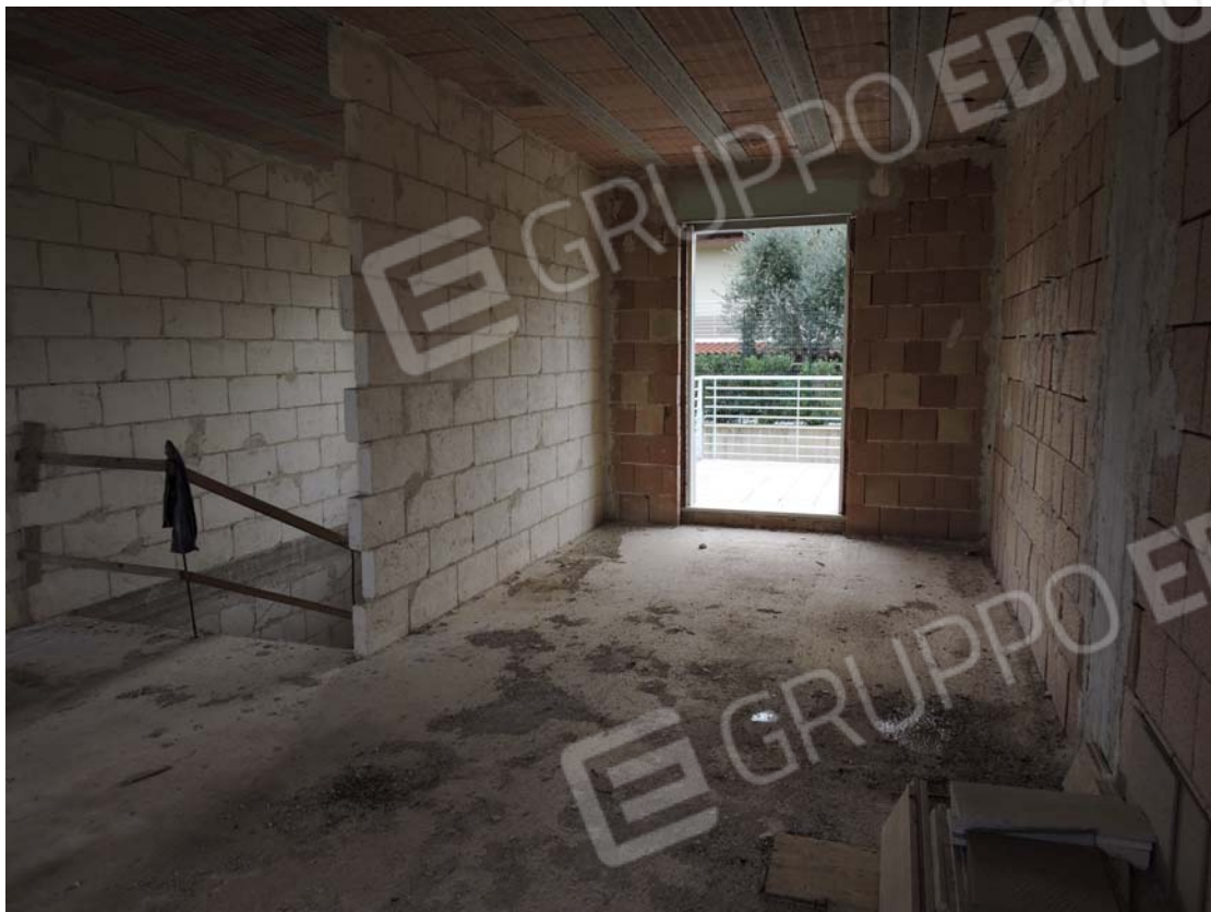
9. interno piano terra
