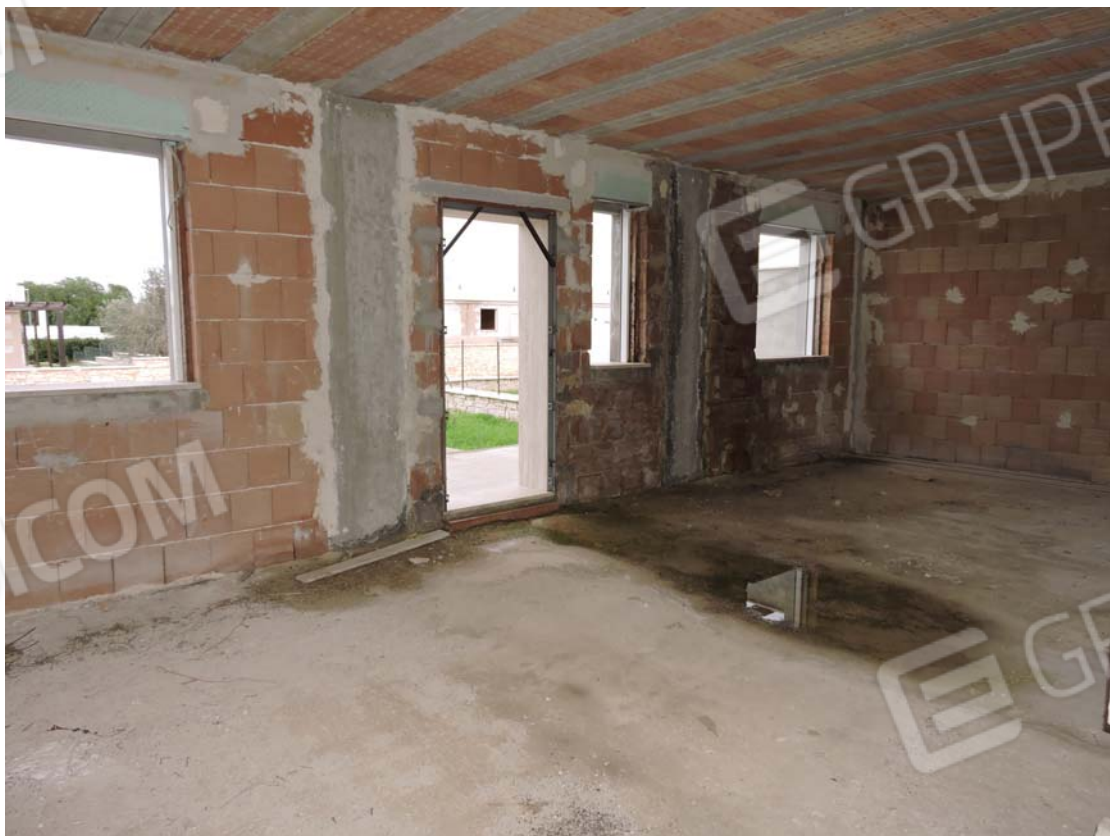
10. interno piano terra
