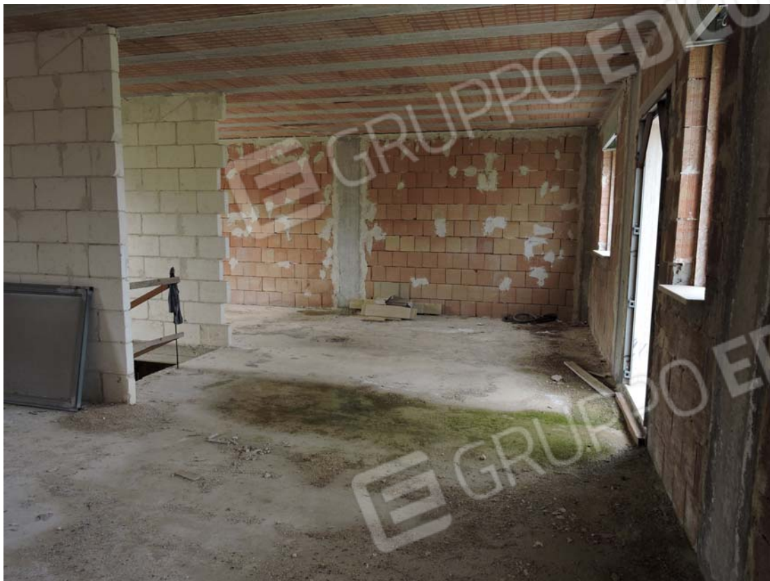
11. interno piano terra
