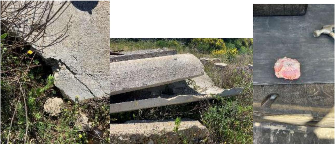
Figura 33: Manufatto in Cemento armato e campione prelevato per verifica assenza Amianto
