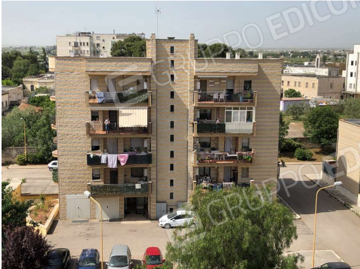
Foto n. 5 – Blocco B: prospetto principale su piazza Peppino Impastato
