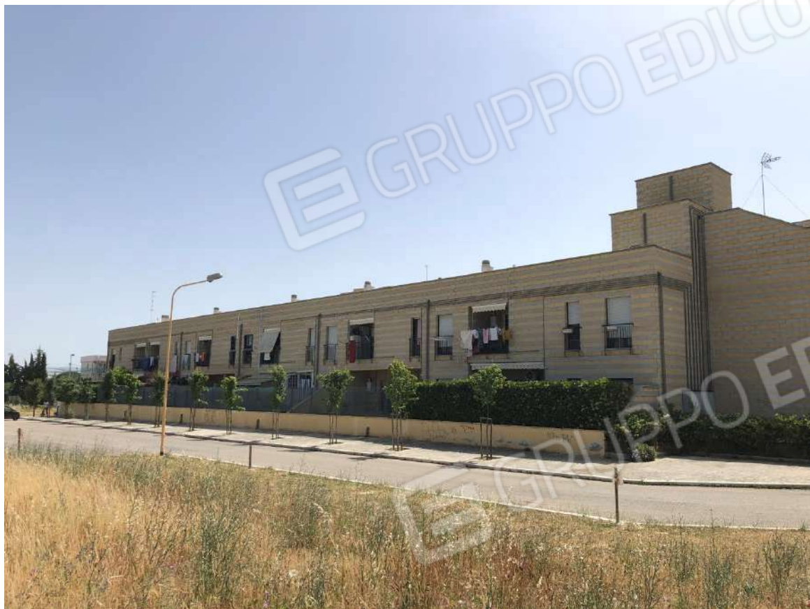
Foto n. 3 – Blocco A: prospetto retrostante
