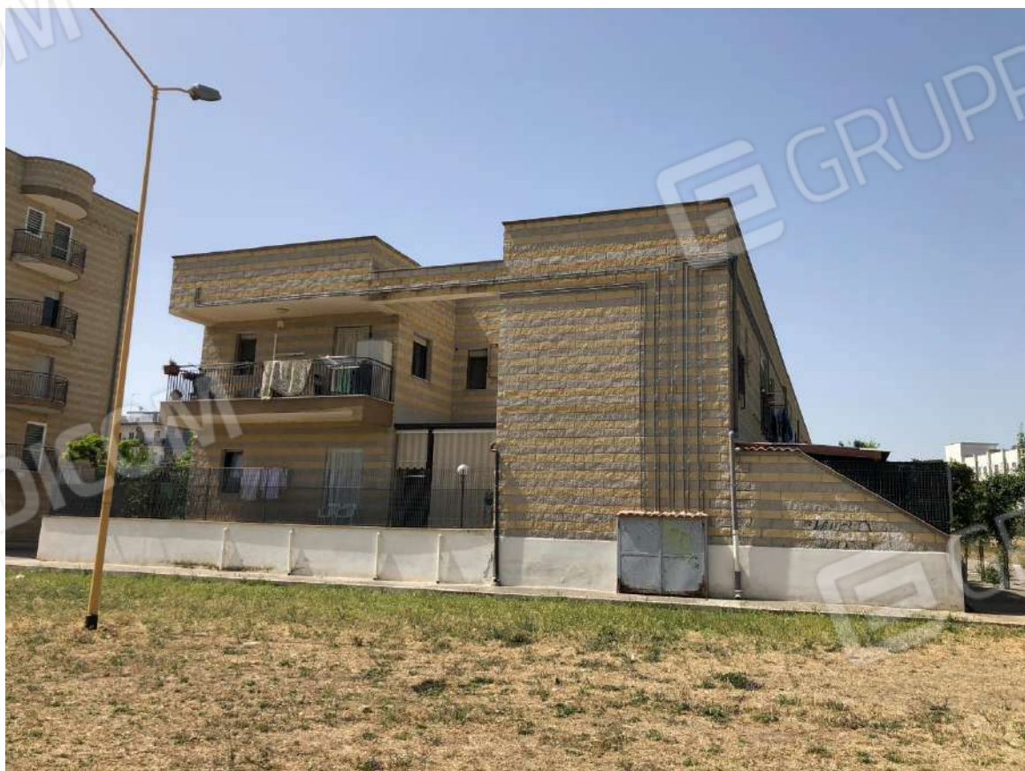
Foto n. 4 – Blocco A: prospetto laterale
