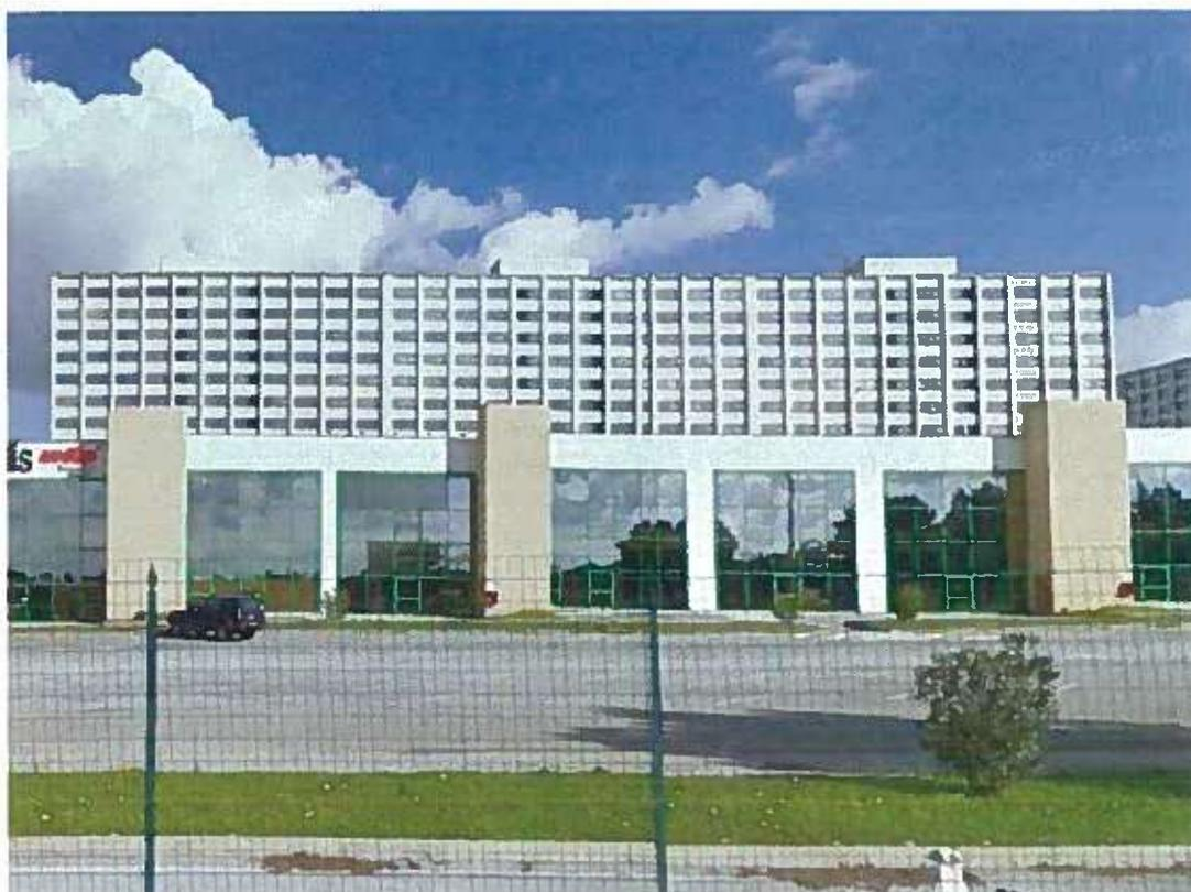
La porzione "Scala B" oggetto di valutazione occupa la parte centrale dell'intero fabbricato ed è strutturalmente giuntato con le porzioni adiacenti. Il corpo oggetto di esame (scala B) ha un fronte prospettico di c.a 53,60 mt e si estende trasversalmente per c.a 16,80 mt. L'altezza totale dell'edificio è di circa 47 mt, l'altezza utile al piano terra, misurata sottotrave è di 4,40 mt, l'altezza utile ai piani superiori misurata sottotrave è di mt 2,80.
