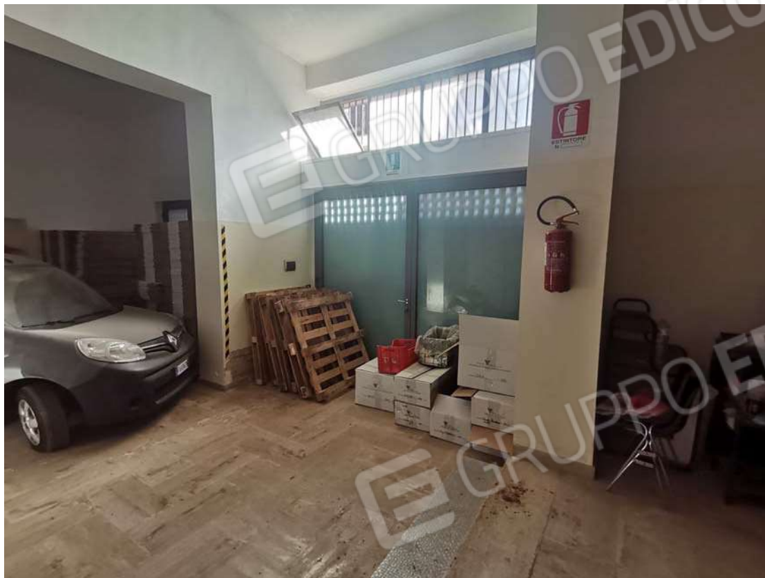
15. zona deposito (parte centrale)
