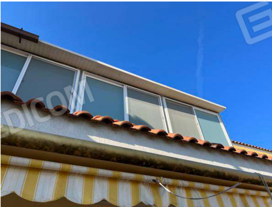
Foto 14 – Vista veranda realizzata a piano secondo
