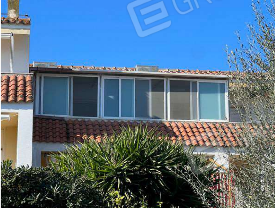
Foto 13 – Vista veranda realizzata a piano secondo
