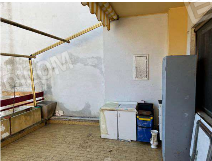
Foto 6 – Vista terrazzino pertinenziale a livello a piano primo
