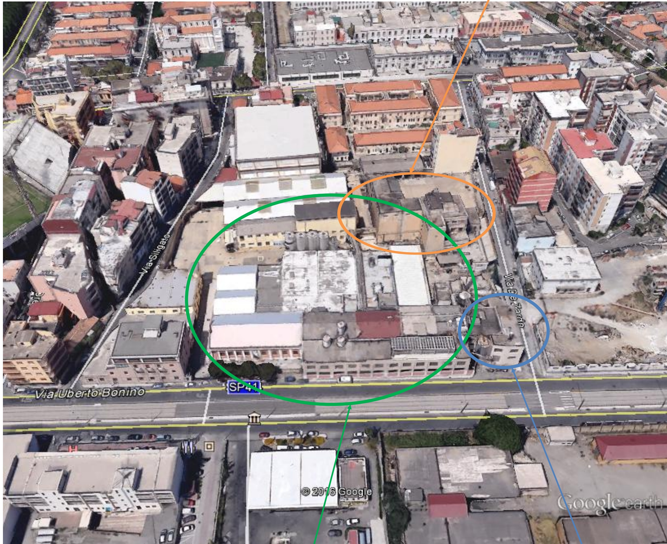
Edifici interni, prospicienti via De Zardo
