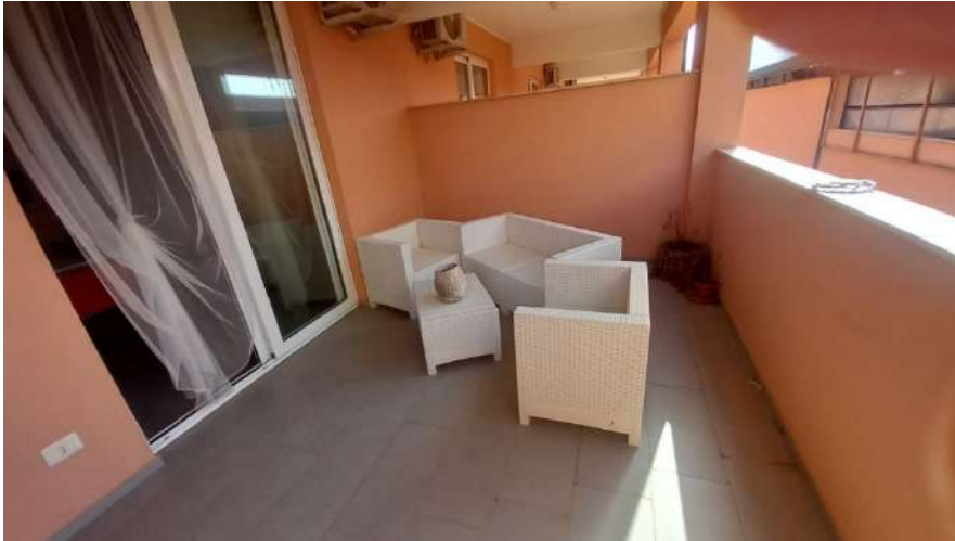
Particolare terrazzo coperto
