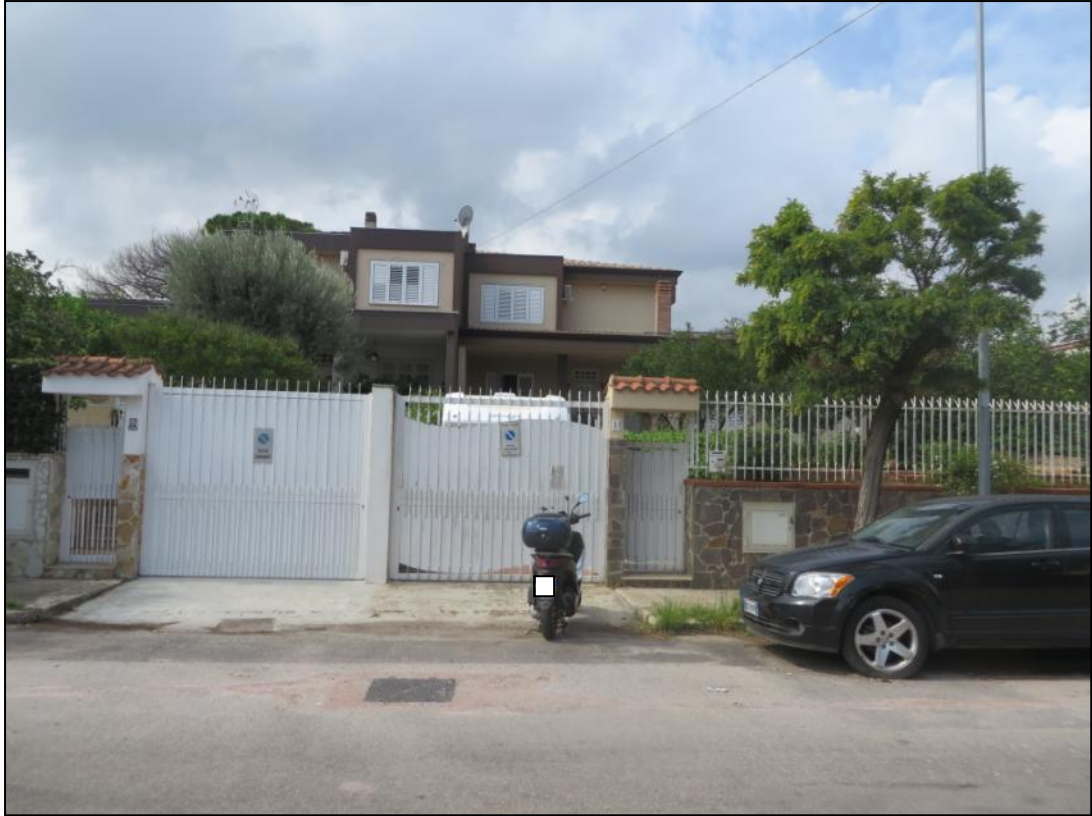
Accesso dell'unità immobiliare da via Nettuno
