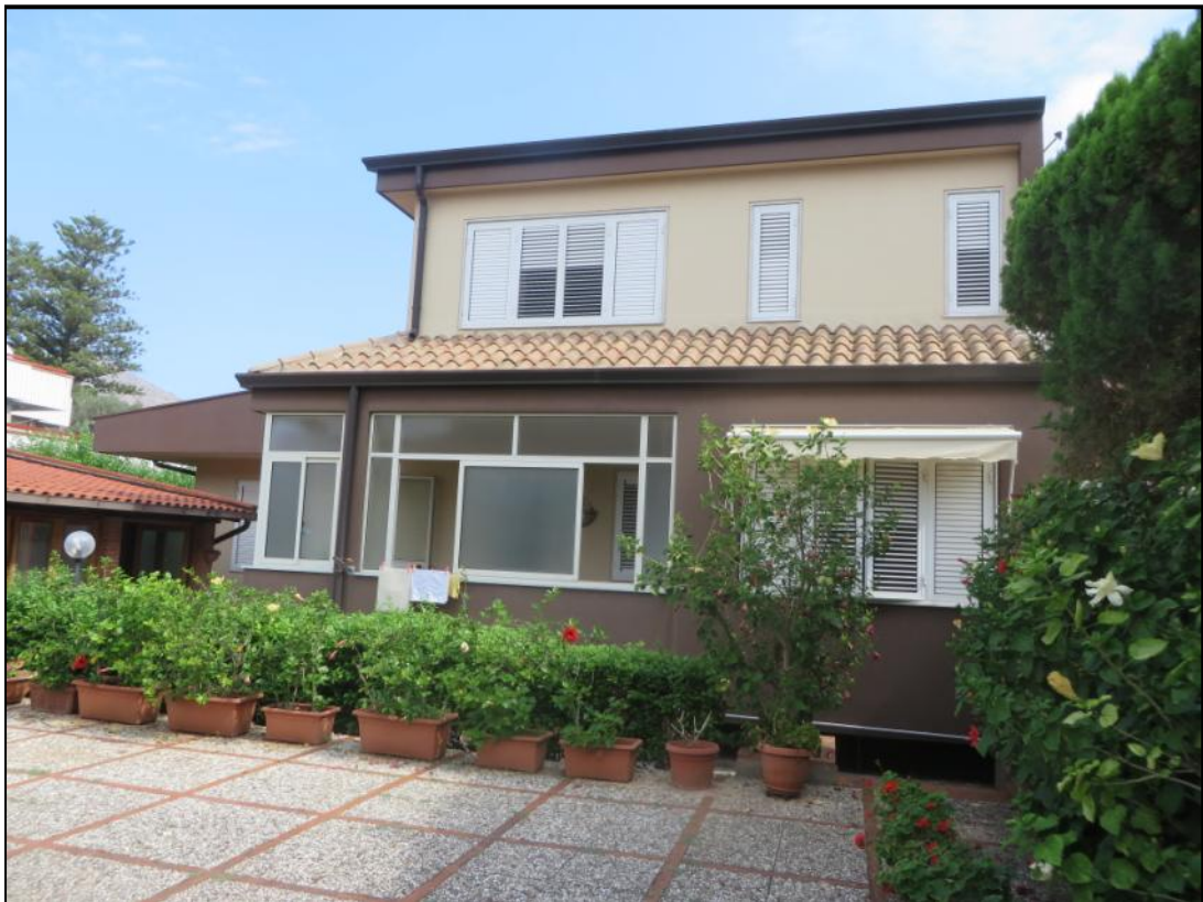
Retrospetto dell'unità immobiliare
