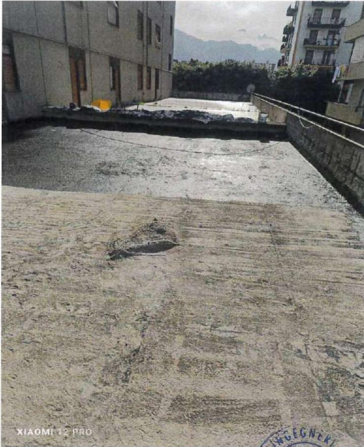
Demolizione e impermeabilizzazione della pavimentazione del terrazzo di piano primo
