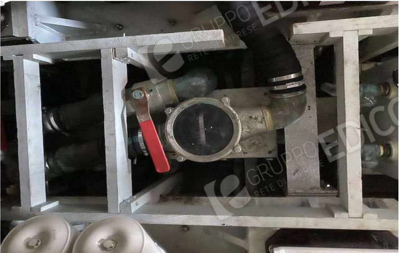
VISTA PRESA MARE
