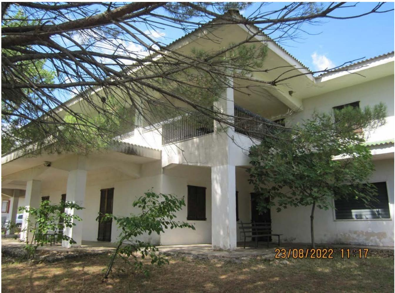
La palazzina si presenta in discreto stato di manutenzione, di fatti come si evince dal report fotografico allegato, sono diffuse delle lesioni sulle facciate e sui pilastri, gli infissi esterni sono degradati, gli intonaci sono lesionati ed ammalorati.
