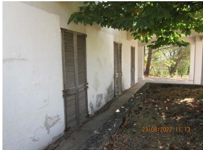
La pavimentazione esterna del portico è stata realizzata in C.L.S., essa appare fortemente lesionata e degradata.
