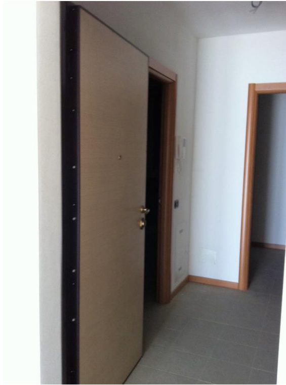
Vista ingresso unità immobiliare
