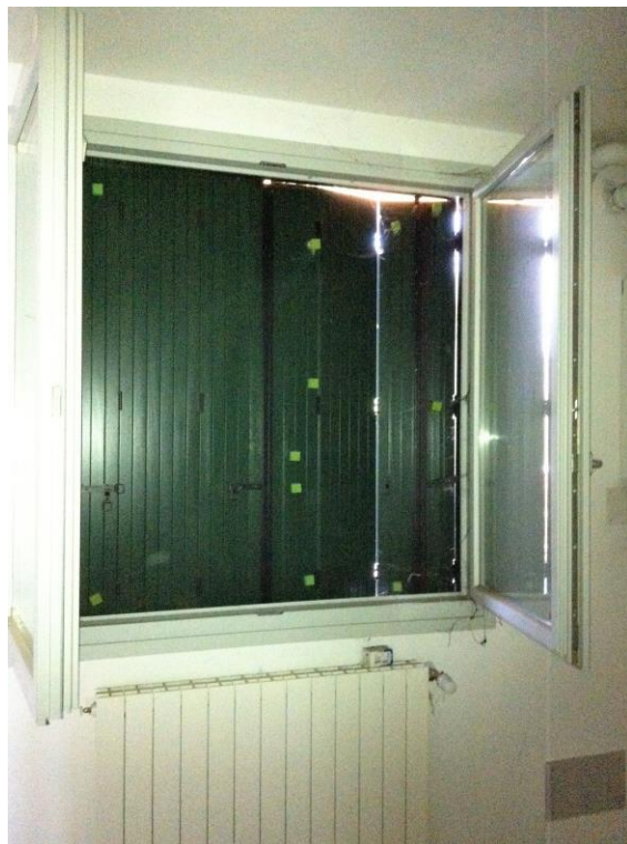
Vista particolare primo locale
