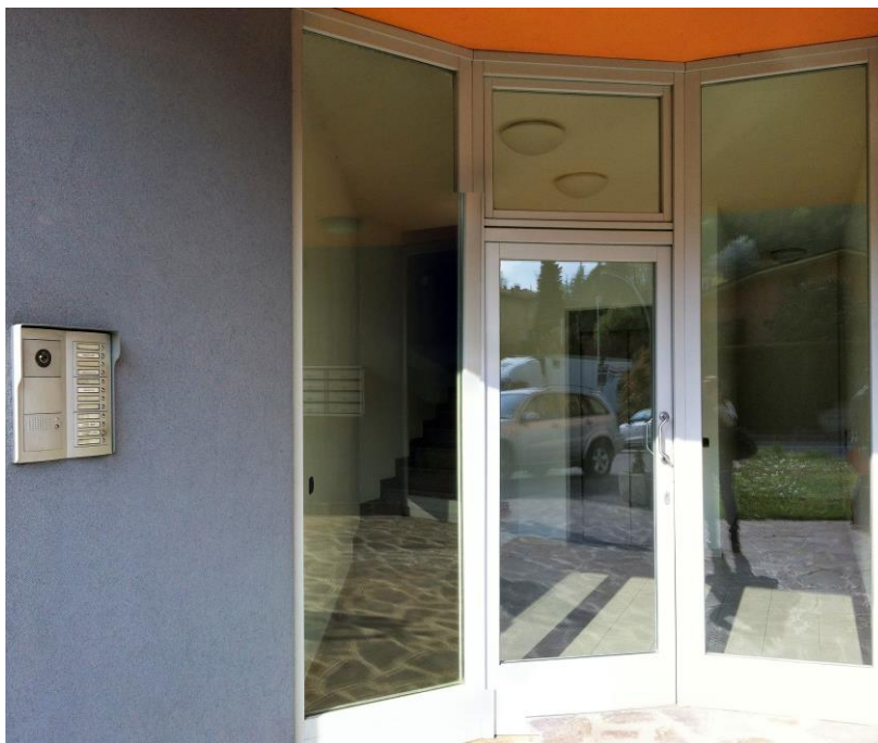
Vista entrata principale
