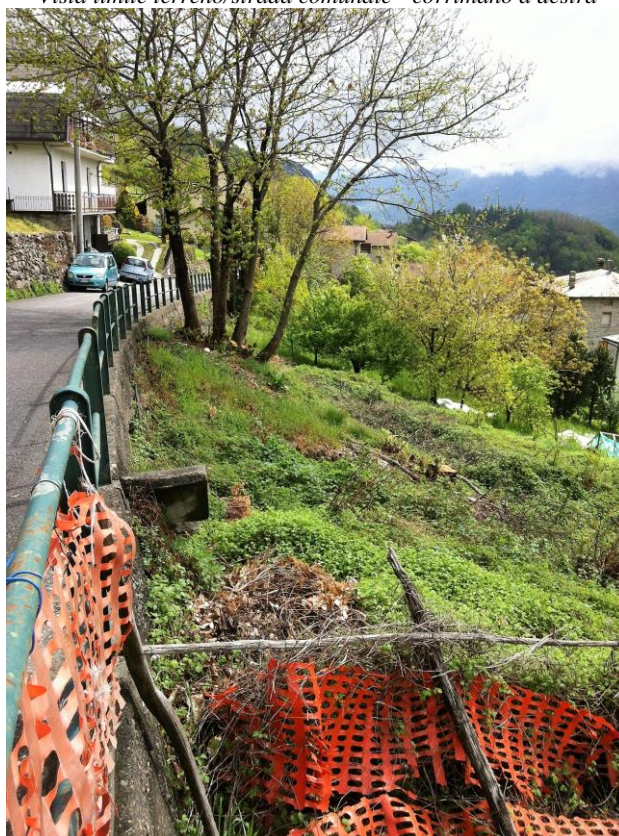
Vista limite terreno: strada comunale - cesata rossa
