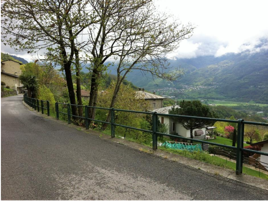
Vista dalla salita di via Bona - limite terreno/strada comunale (albero sulla destra)
