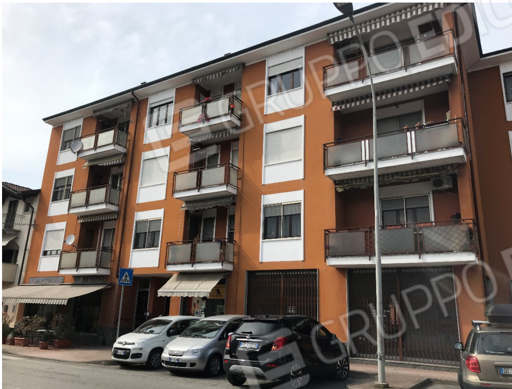
Foto n. 2: Prospetto principale su Via Umberto I
