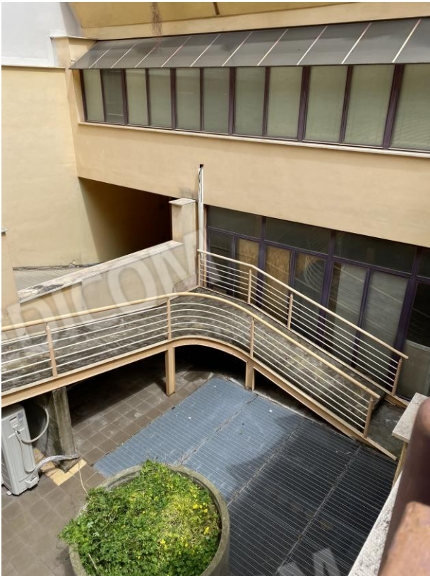
Foto 4.2 – Area esterna scoperta
