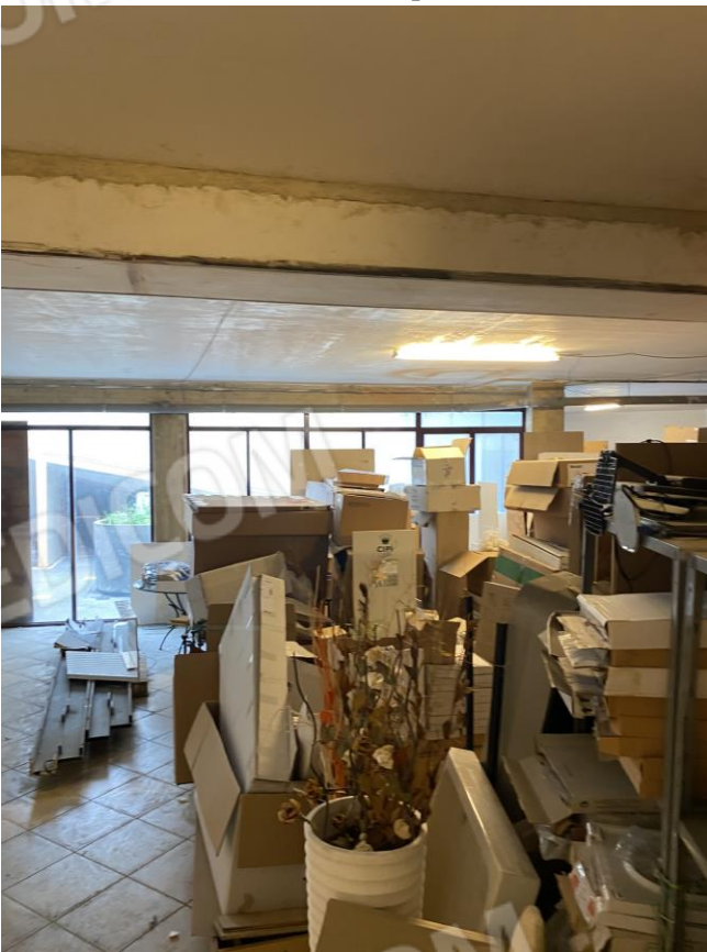
Foto 4.6 – Interno della zona deposito
