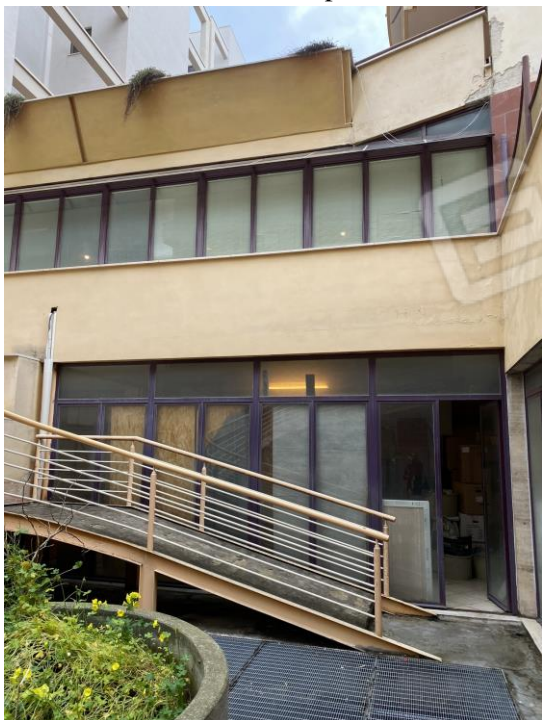
Foto 4.3 – Area esterna scoperta
