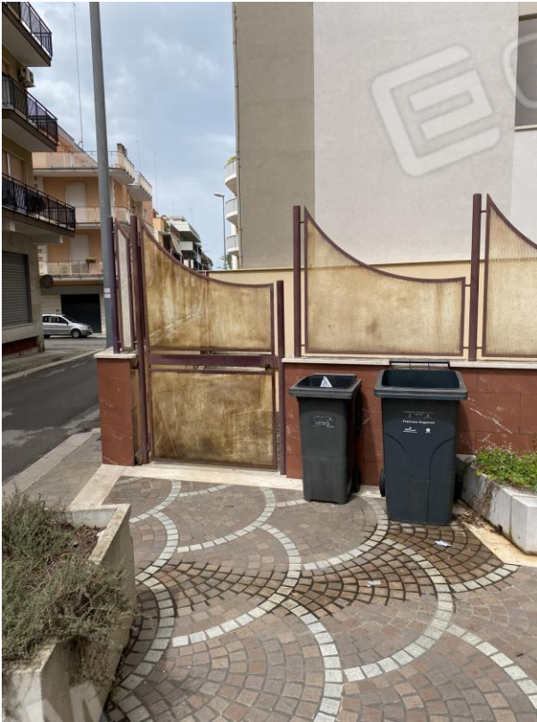
Foto 4.1 – Ingresso esterno a piano terra
