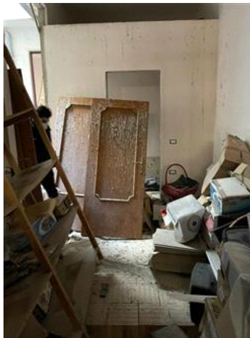
Varco di accesso dal SUB29 al SUB26 piano T
