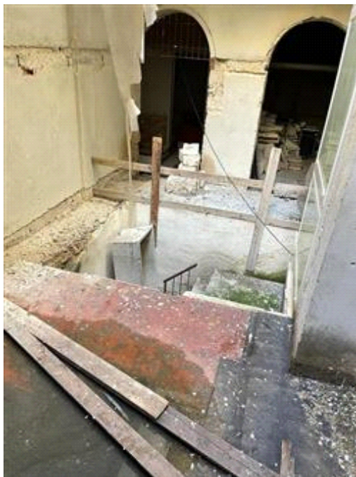
Varchi di accesso a SUB9 e SUB5
