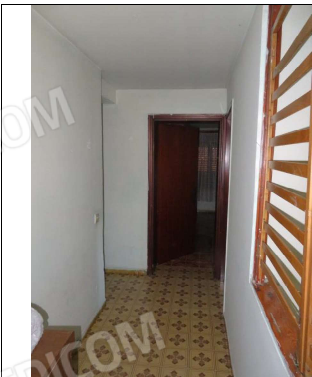
Foto n°20: Disimpegno al P.1°
