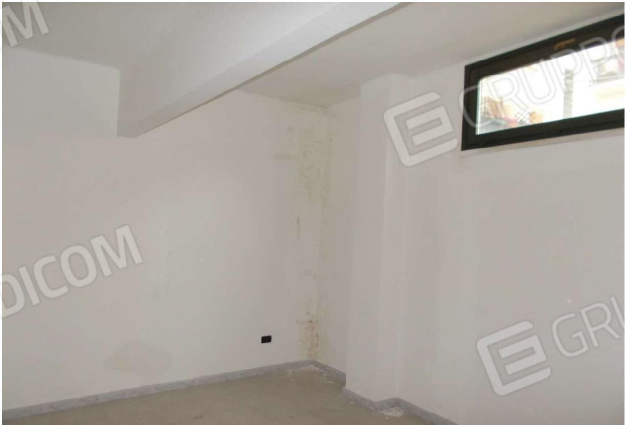
8. Particolare interno - locale caratterizzato da infiltrazione d'acqua nell'angolo della parete
