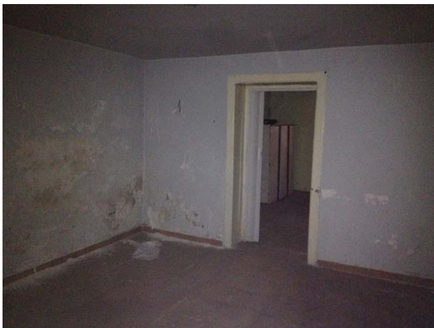
foto 5: unità sH: vano intercluso (quadri umidi diffusi)
