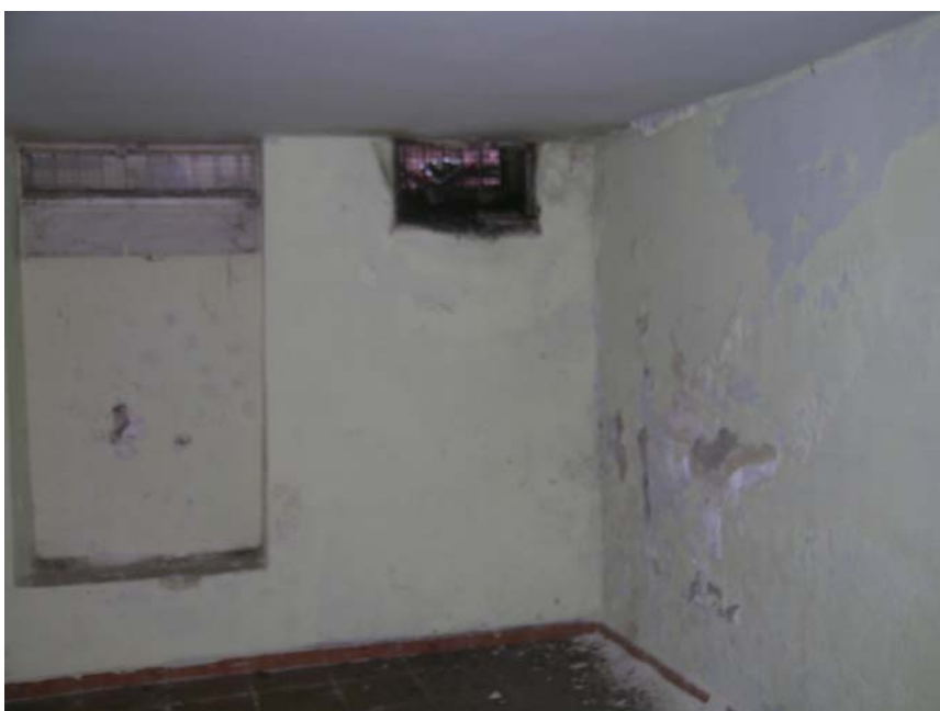
foto 6: unità sH: vano alla via Cagnazzi (quadri umidi e finestrini al livello marciapiede)
