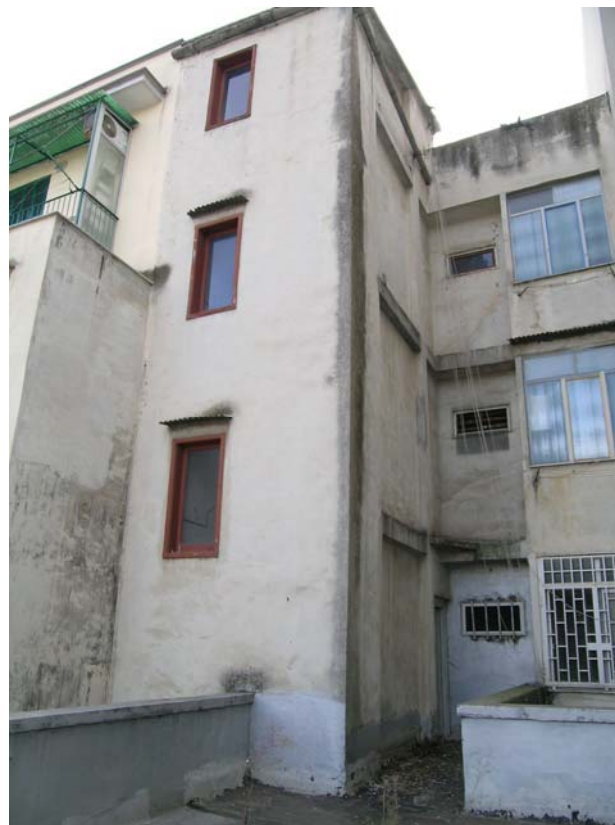
foto 2: prospetto della sopraelevazione (vista dal lastrico di 2° piano)
