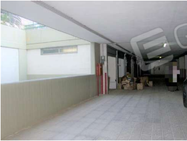
Foto 30 - Vista della corsia di manovra d'accesso ai Beni N. 2 e N. 3
