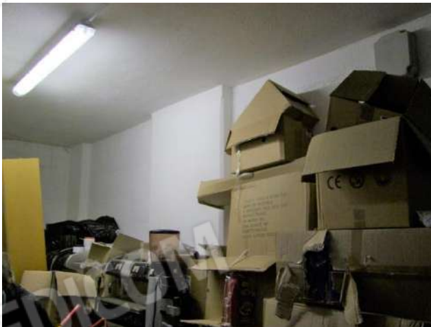
Foto 32 - Vista interna verso la parete orientata a Est
