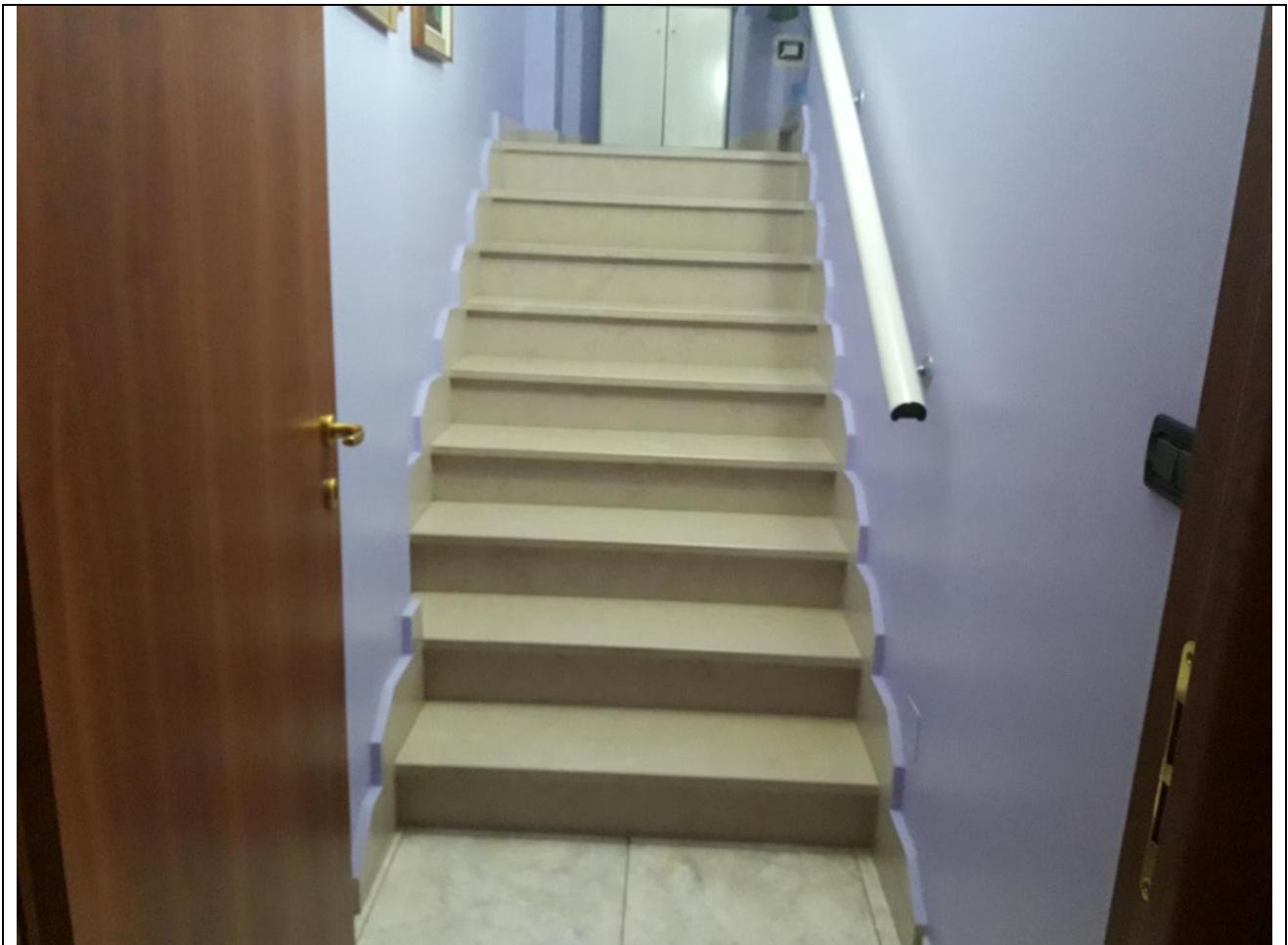
10 – scala che conduce al terzo piano (sottotetto)
