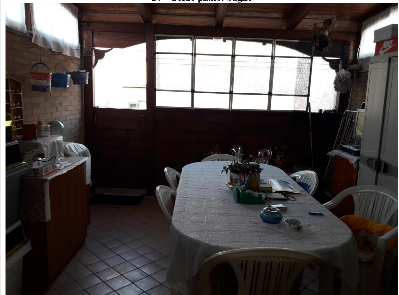
15 – Terzo piano: chiusura della veranda che è stata abusivamente trasformata in un vano soggiorno di mq 15 circa.
