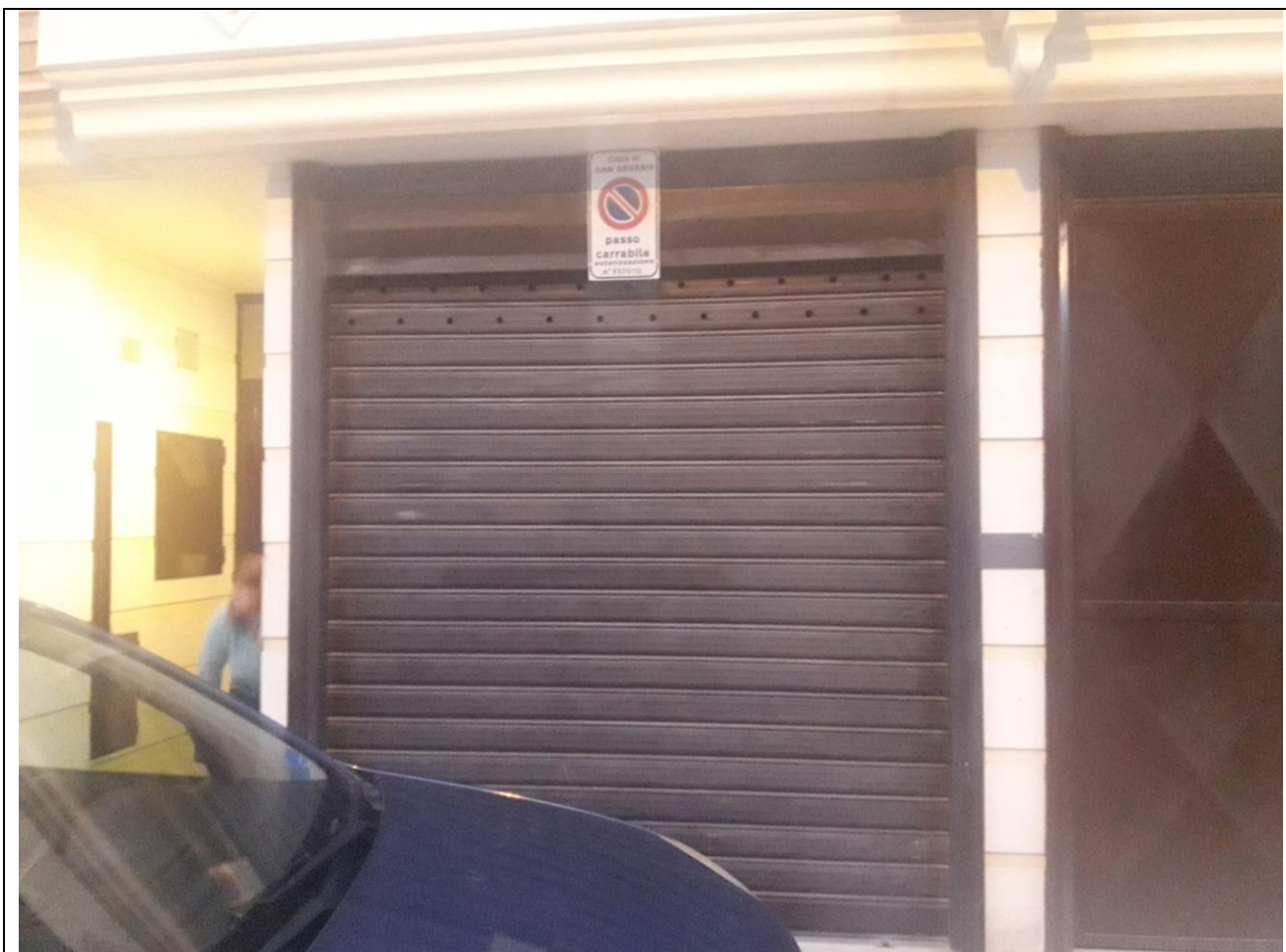
16 – Serranda di ingresso al box auto indicato con il civico 278/A
