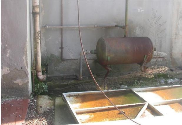
**Fig. 26 serbatoio di condensa arrugginito**
