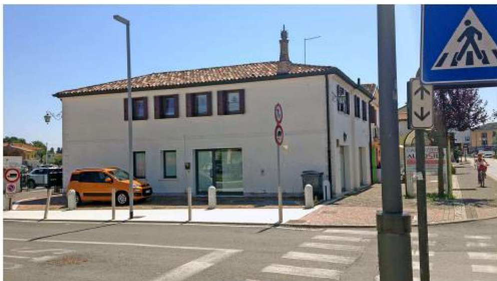
Fabbricato Ex Sildomus – Foto 03 angolo nord-ovest
