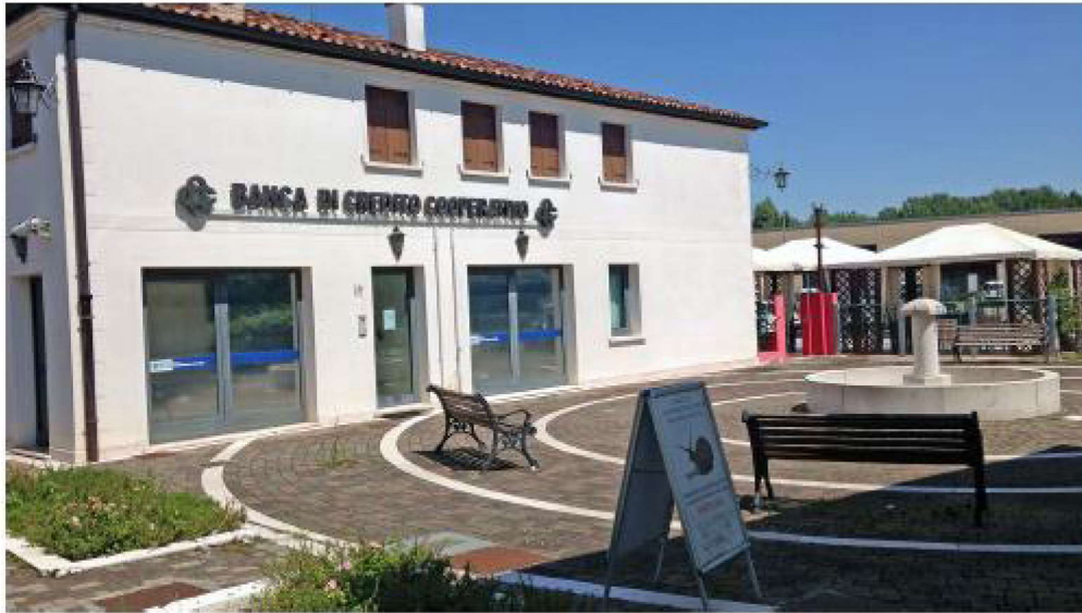
Fabbricato Ex Sildomus – Foto 01 esterno lato sud
