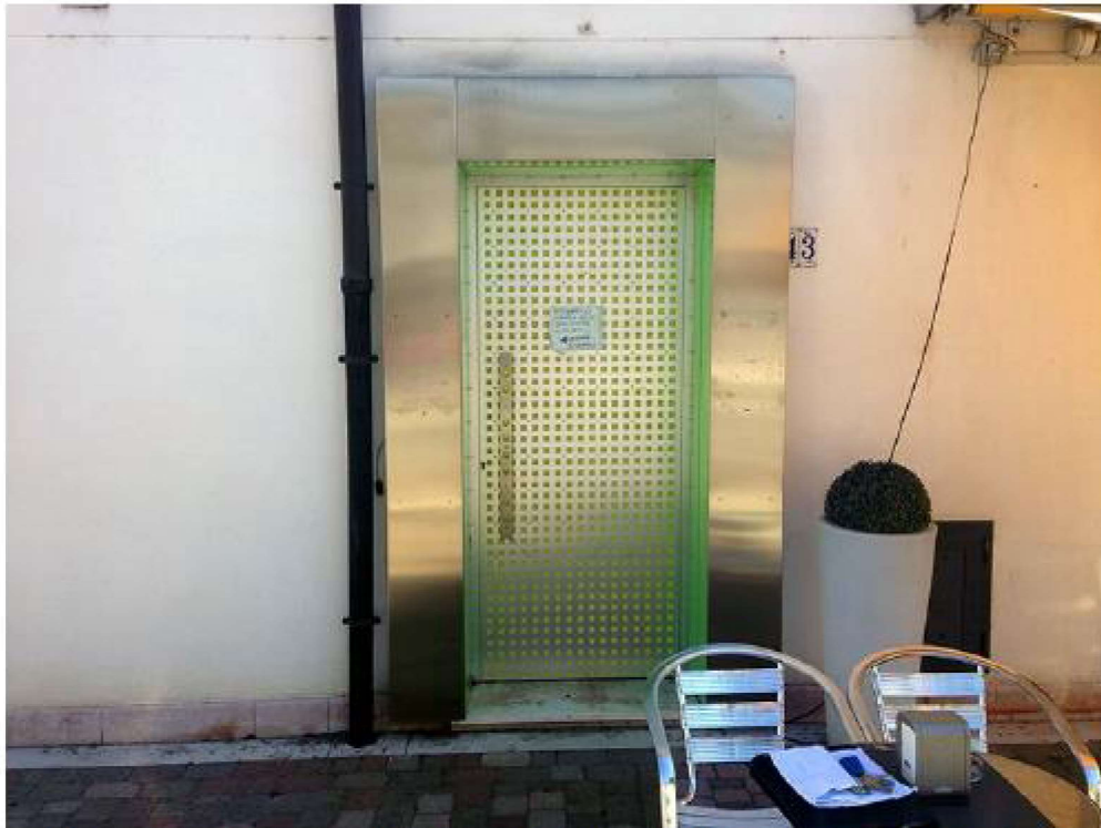
Negozio/Ex parrucchiera Sub 26 – Il portone di ingresso sul lato principale.
