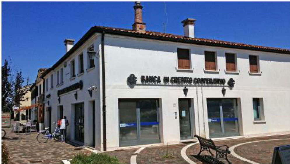
Fabbricato Ex Sildomus – Foto 02 esterno angolo sud-ovest
