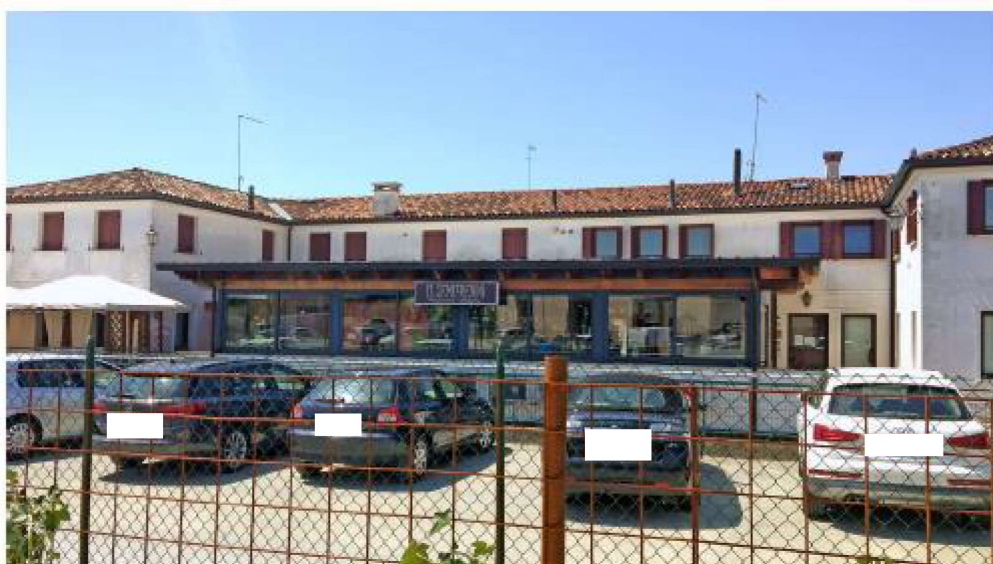
Fabbricato Ex Sildomus – Foto 04 esterno lato est
